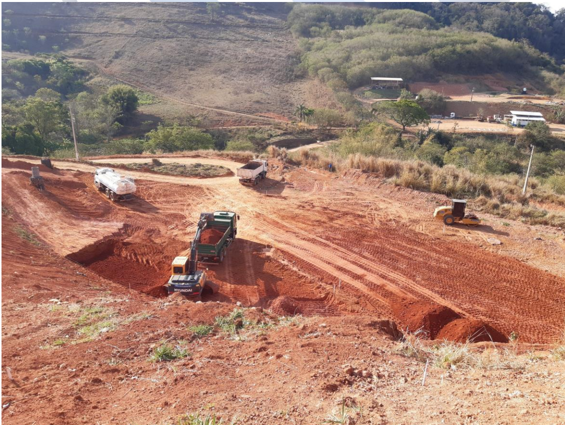
Foto 02: Escavação e compactação na base da área norte do aterro sanitário
