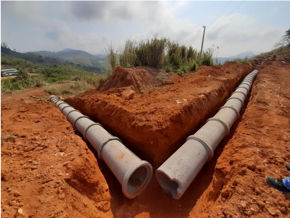
Foto 09: Abertura de vala e assentamento de tubos para drenagem pluvial
