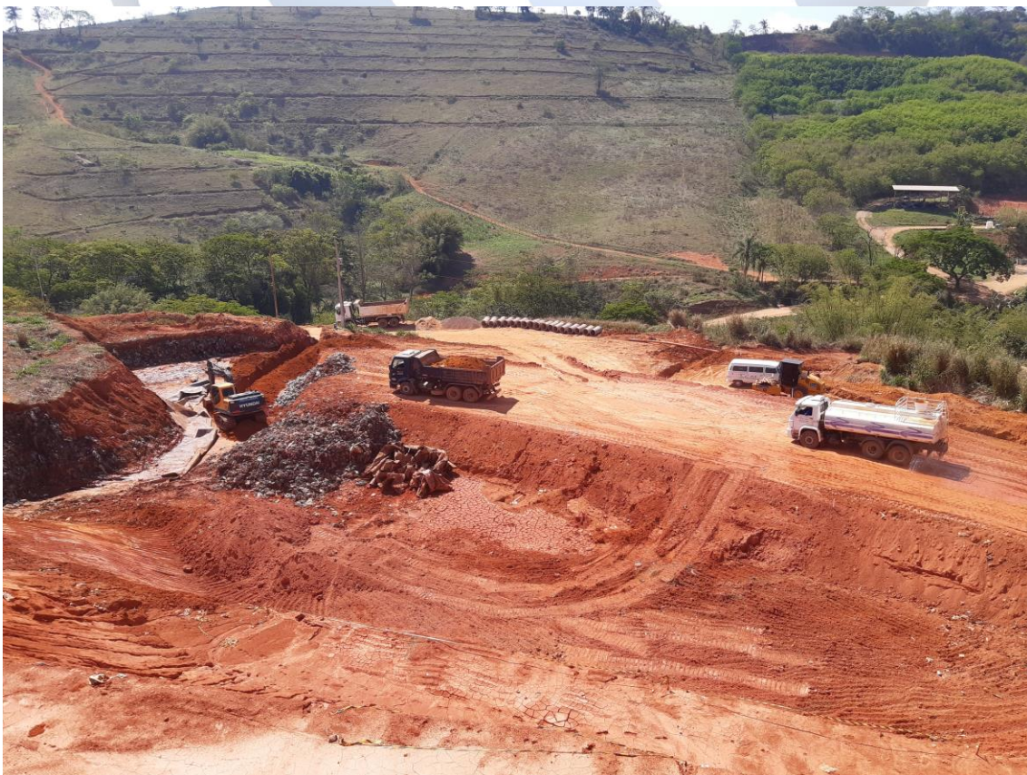
Foto 06: Continuação da execução do dique de solo e Abertura de vala para o dreno
