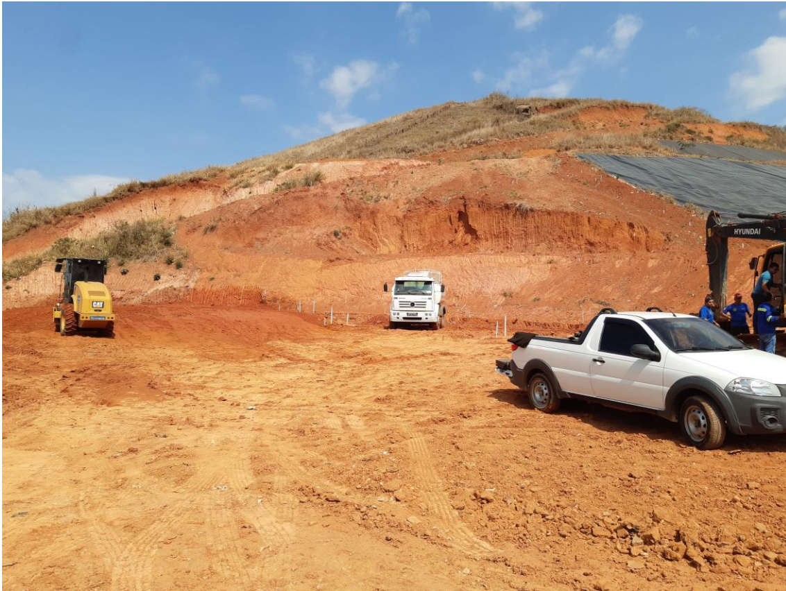
Foto 01: Início dos serviços de terraplenagem no dia 26/09/2022
