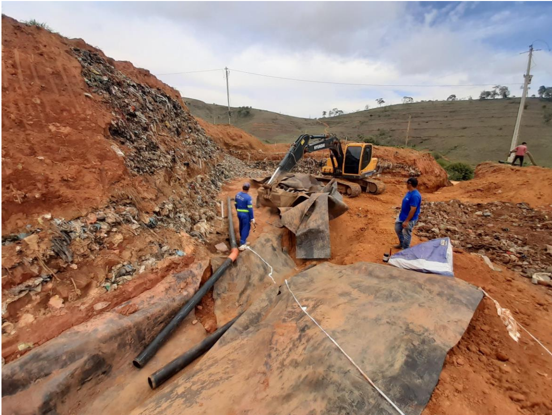
Foto 07: Execução de drenos de base
