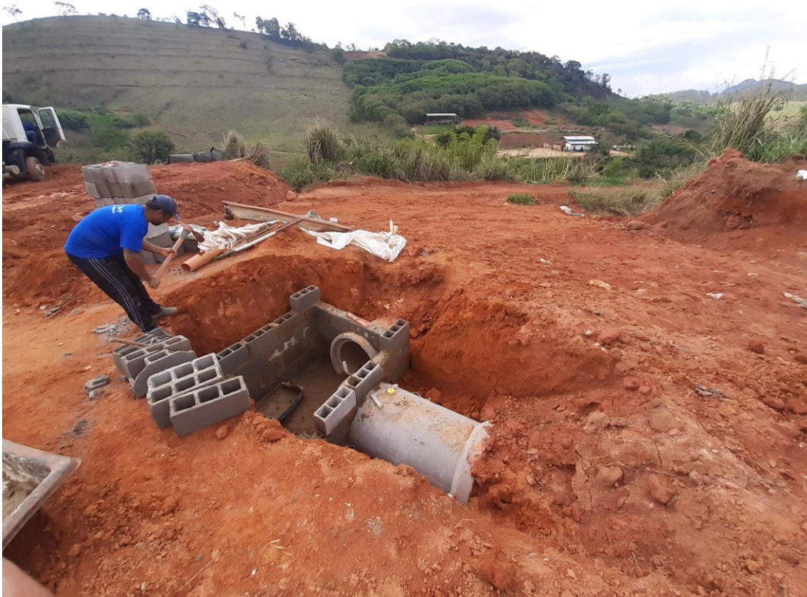
Foto 11: Construção de caixa de passagem das redes de drenagem pluvial
