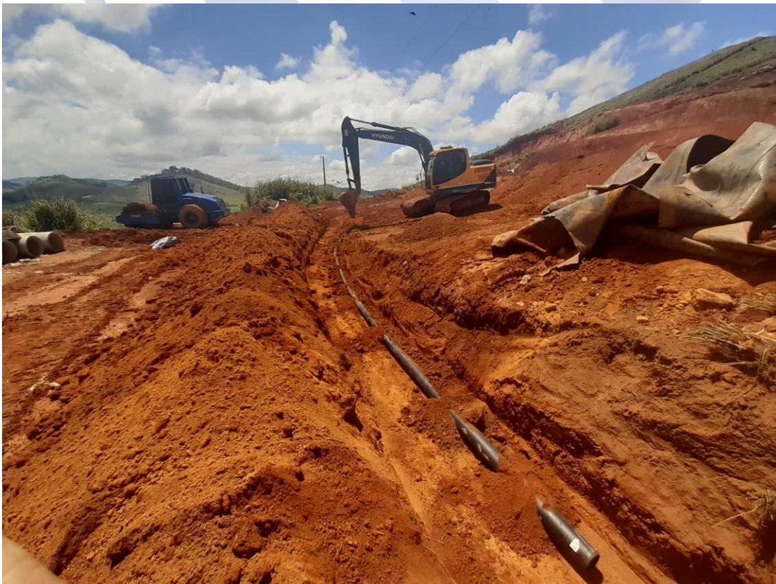
Foto 08: Abertura de vala e assentamento de tubos para drenagem dos lixiviados
