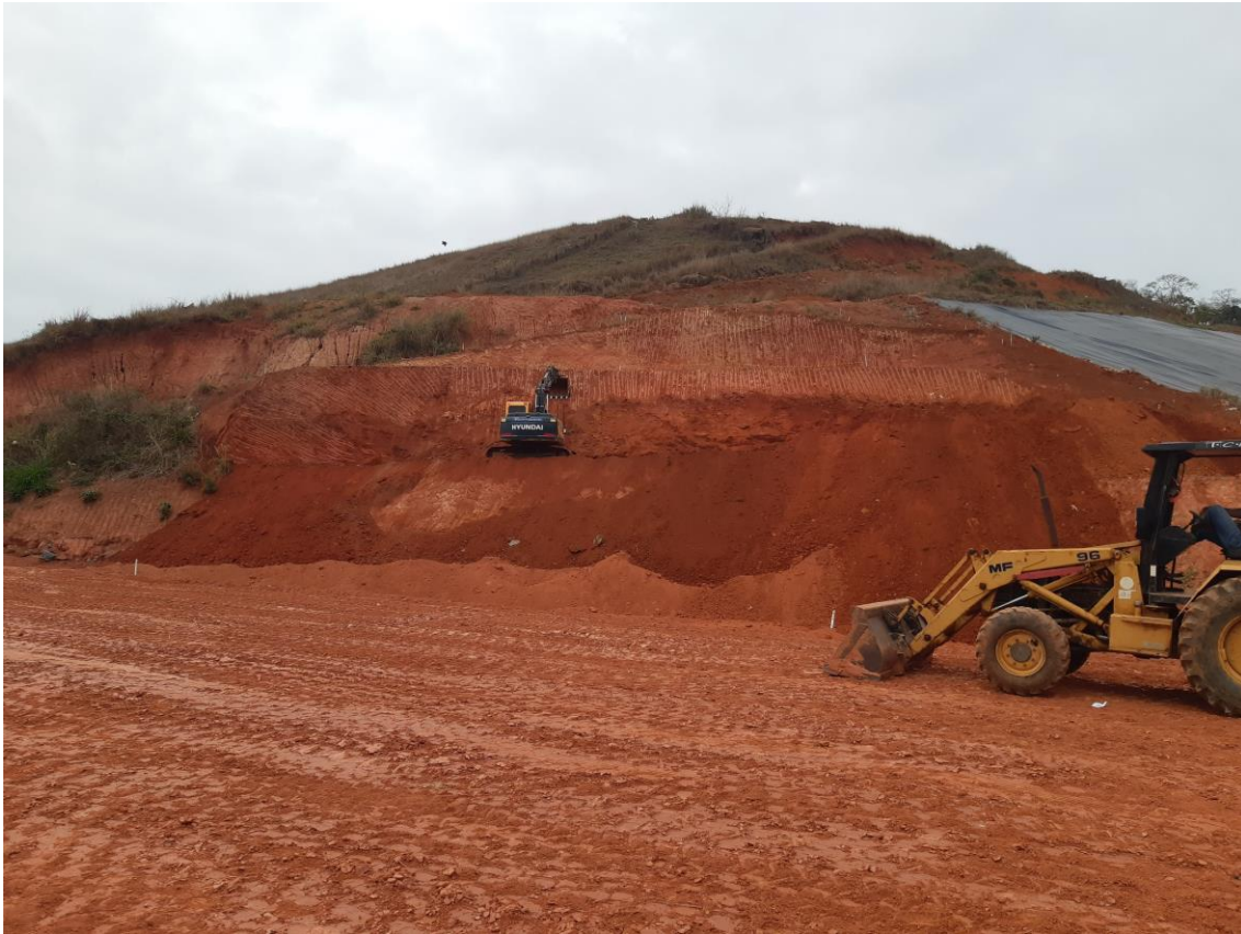
Foto 03: Retaludamento da área norte do aterro sanitário
