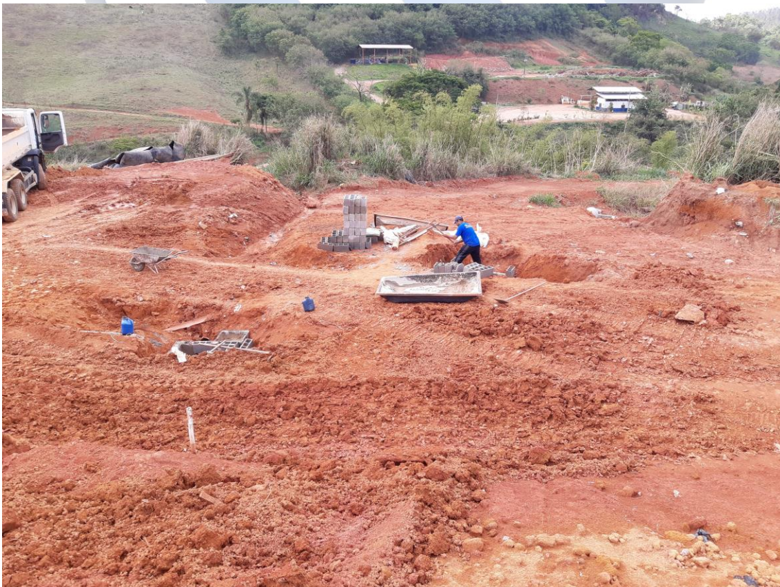
Foto 10: Construção de caixa de passagem das redes de drenagem pluvial e dos lixiviados
