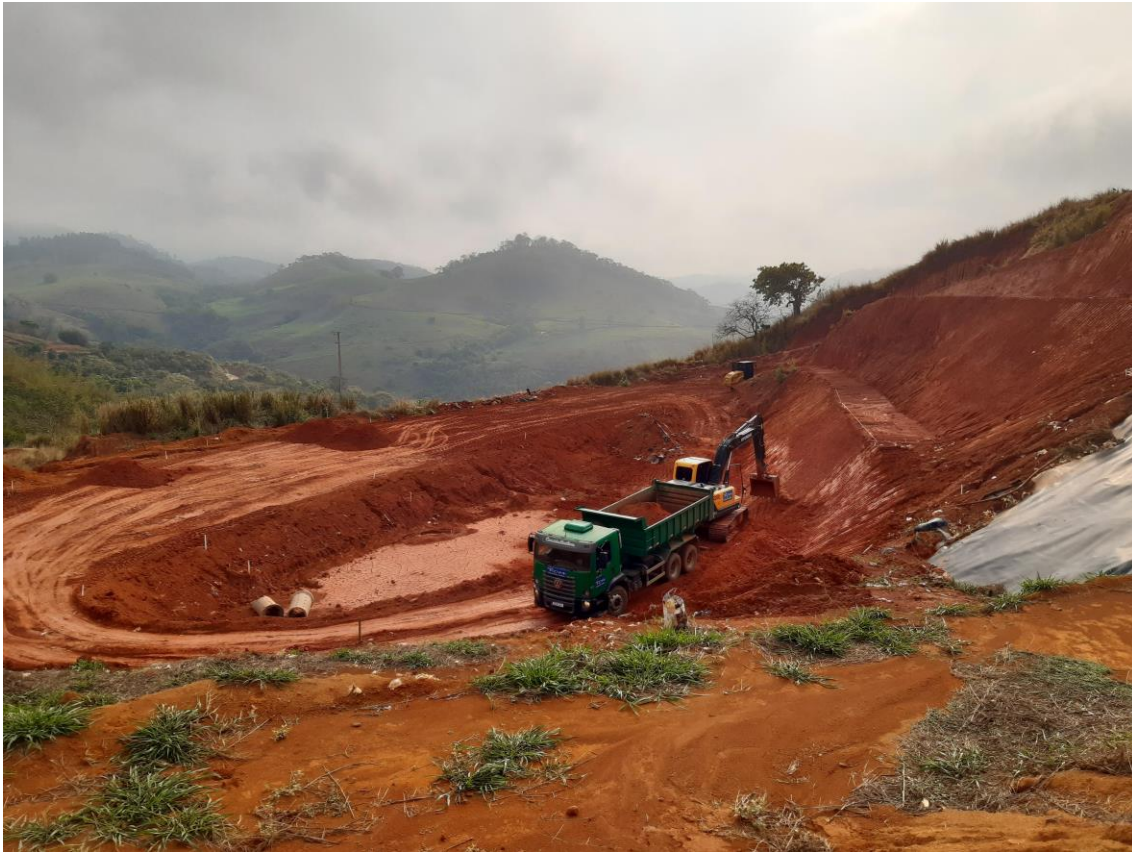
Foto 05: Execução do dique de solo da área norte do aterro sanitário e Retaludamento
