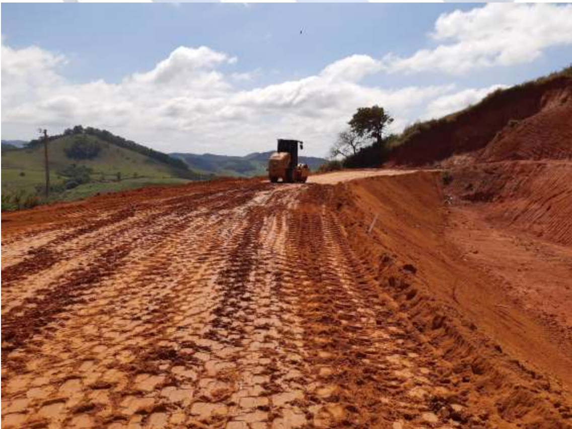
Foto 06: Compactação de solo do dique da área norte do aterro sanitário
