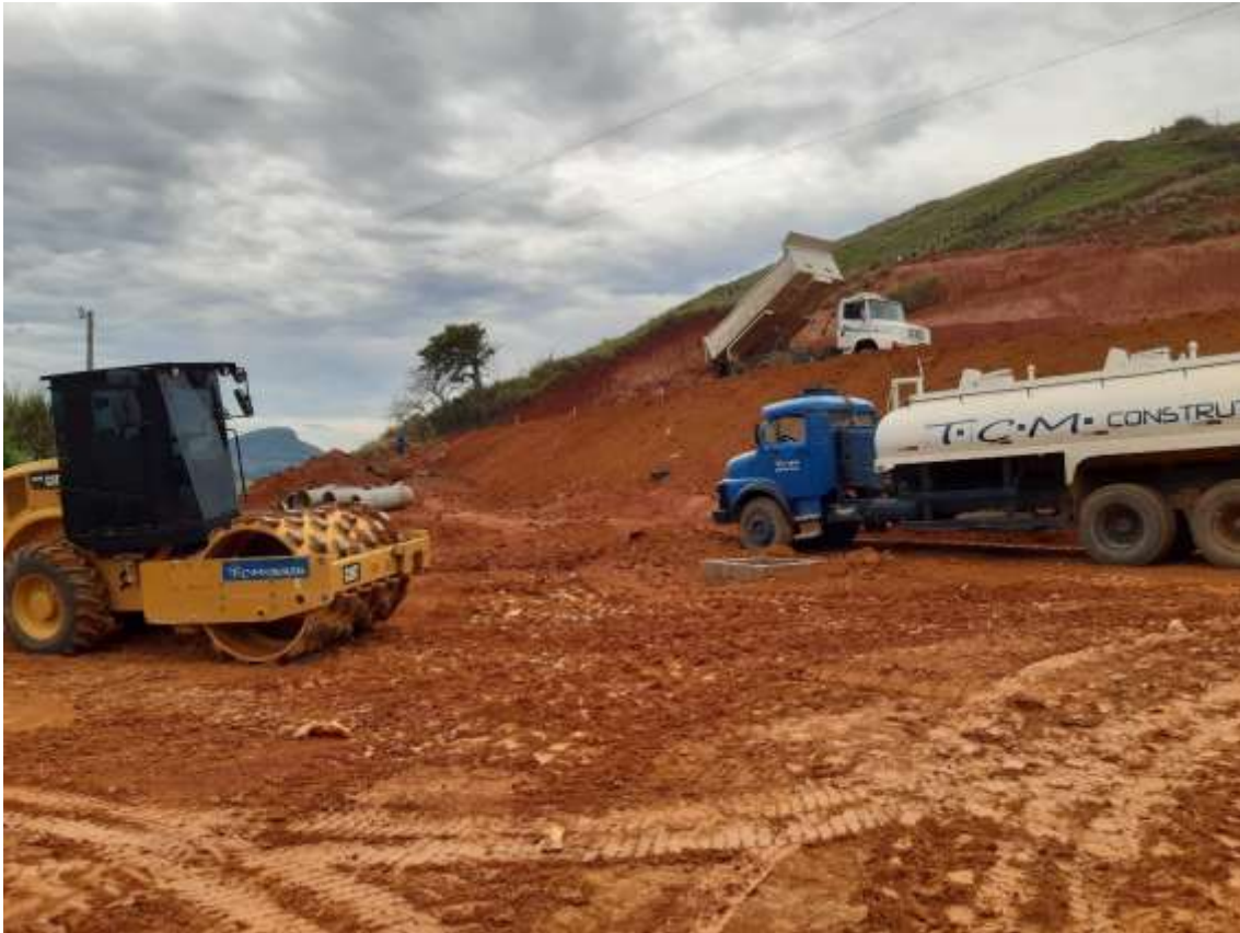
Foto 03: Lançamento de solo para compactação do dique da área norte do aterro sanitário
