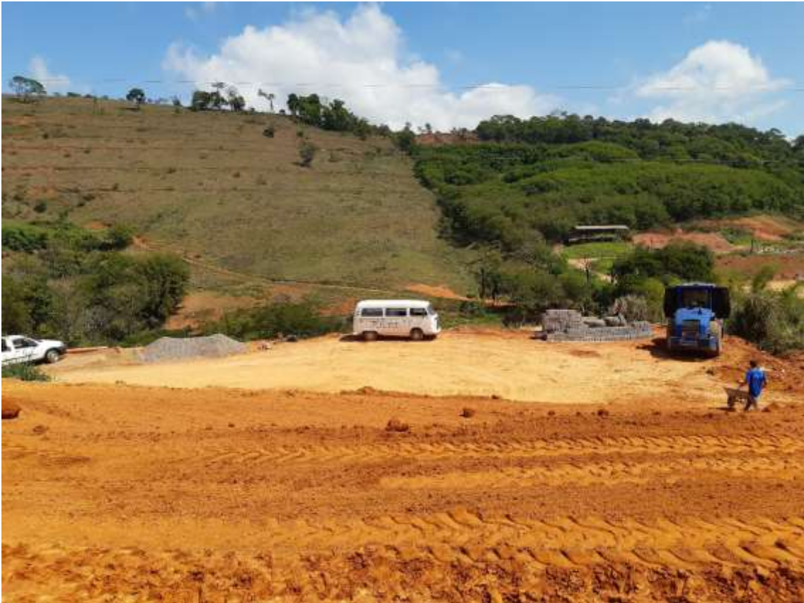
Foto 09: Canteiro de obras para apoio na construção das caixas de passagem e rede de drenagem
