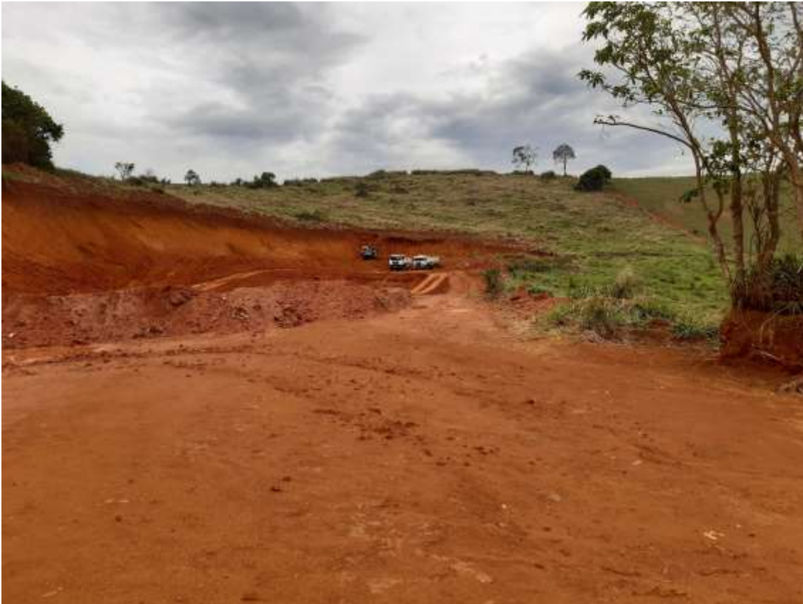
Foto 01: Escavação de material da jazida para construção do dique de solo
