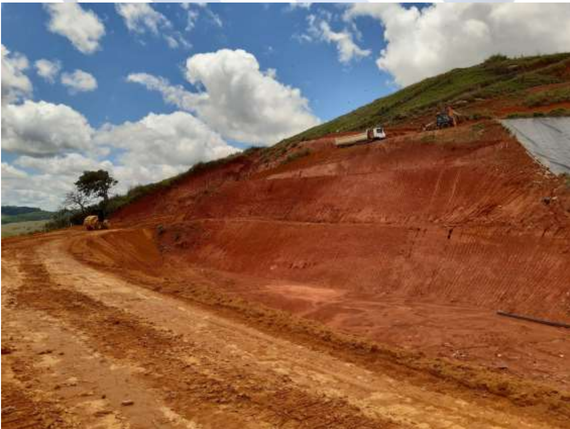
Foto 08: Finalização dos serviços de construção do dique de solo da área norte do aterro sanitário
