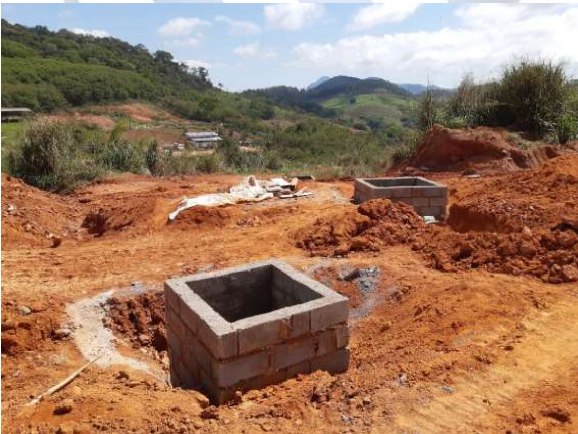
Foto 10: Construção de caixa de passagem e rede de drenagem
