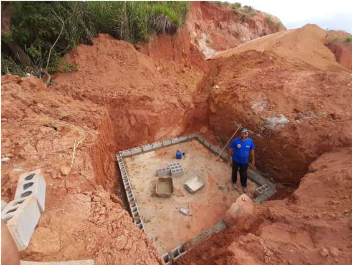
Foto 11: Construção de caixa de passagem e rede de drenagem
