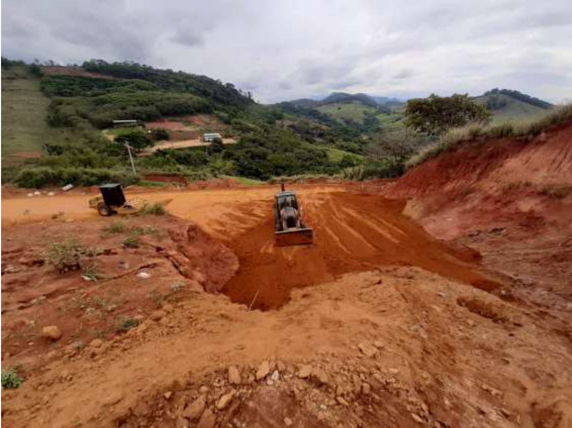
Foto 05: Lançamento de solo para compactação do dique da área norte do aterro sanitário
