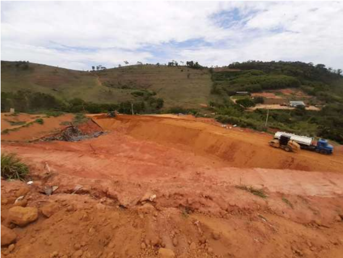
Foto 07: Finalização dos serviços de construção do dique de solo da área norte do aterro sanitário
