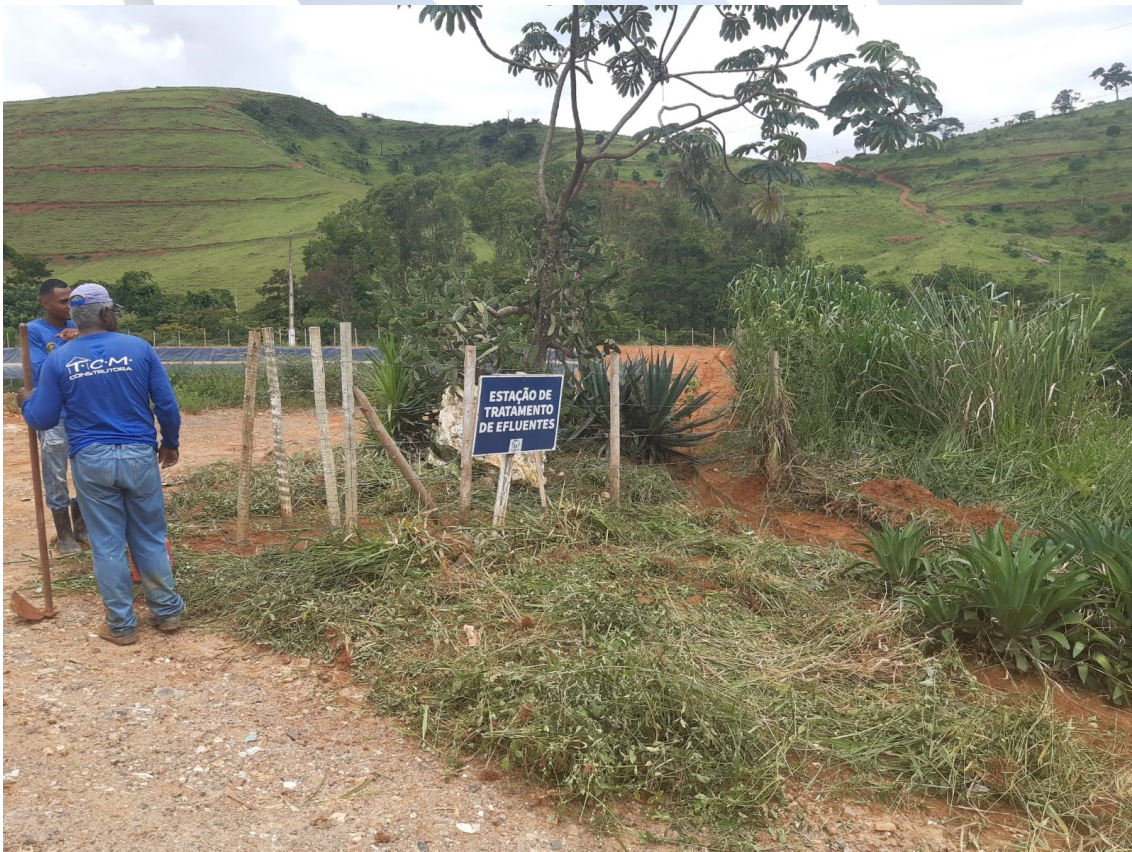
Foto 06: Limpeza da área da Estação de tratamento de efluentes do aterro sanitário
