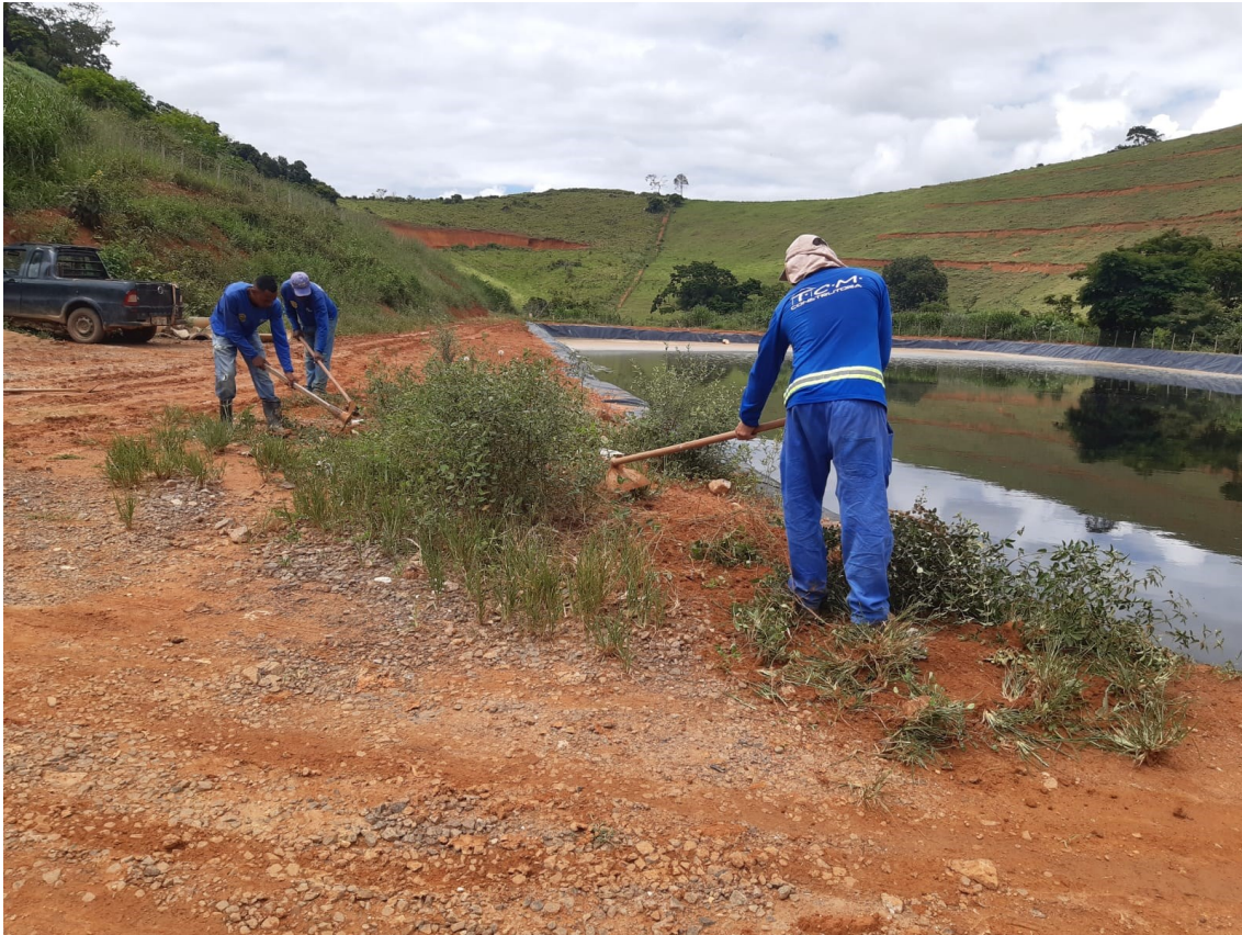
Foto 07: Limpeza da área da Estação de tratamento de efluentes do aterro sanitário
