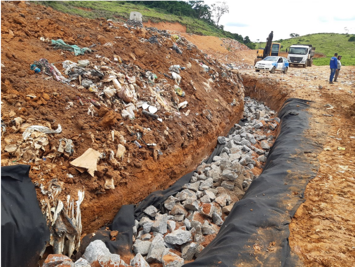
Foto 03: Construção de drenos horizontais no aterro sanitário
