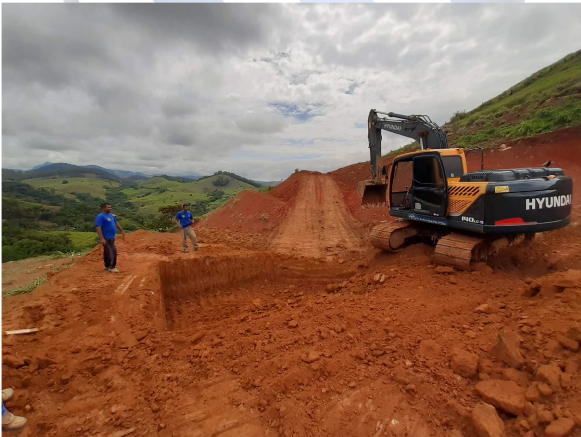
Foto 04: Construção de caixa de retenção de água pluvial
