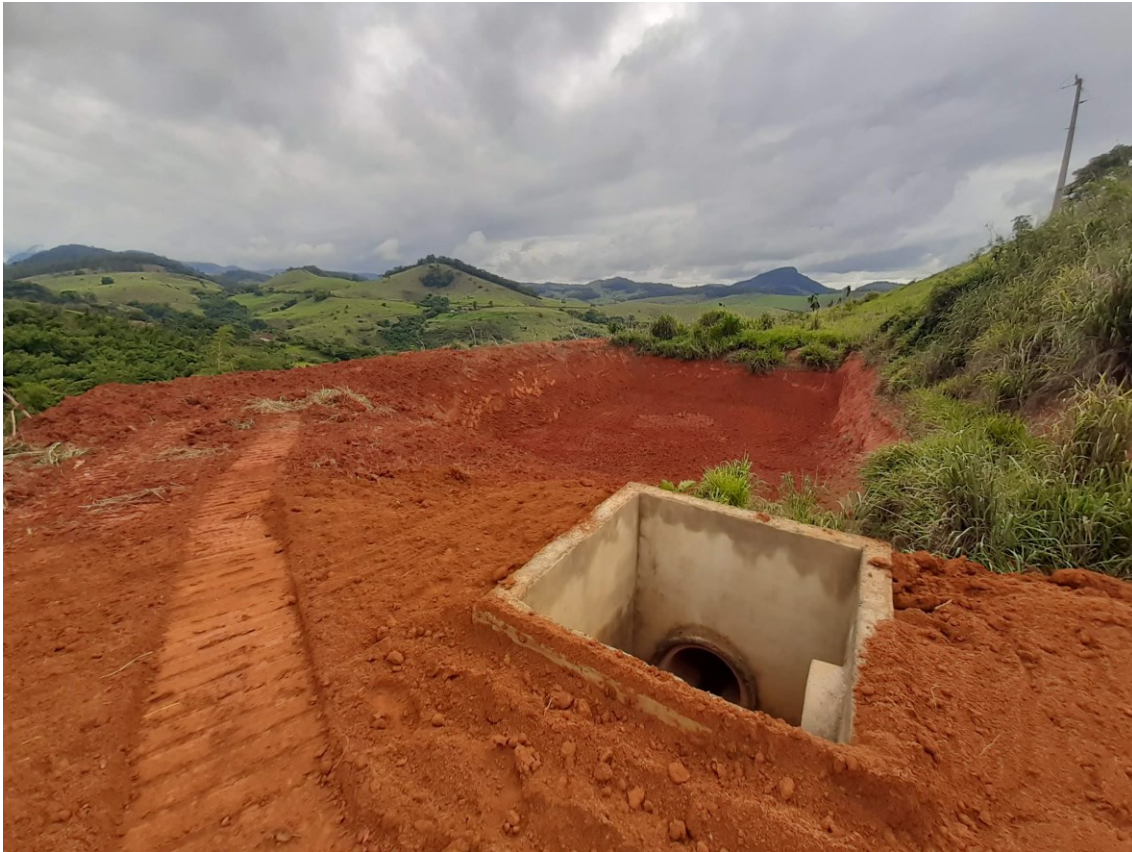
Foto 05: Construção de caixas de passagem de água pluvial
