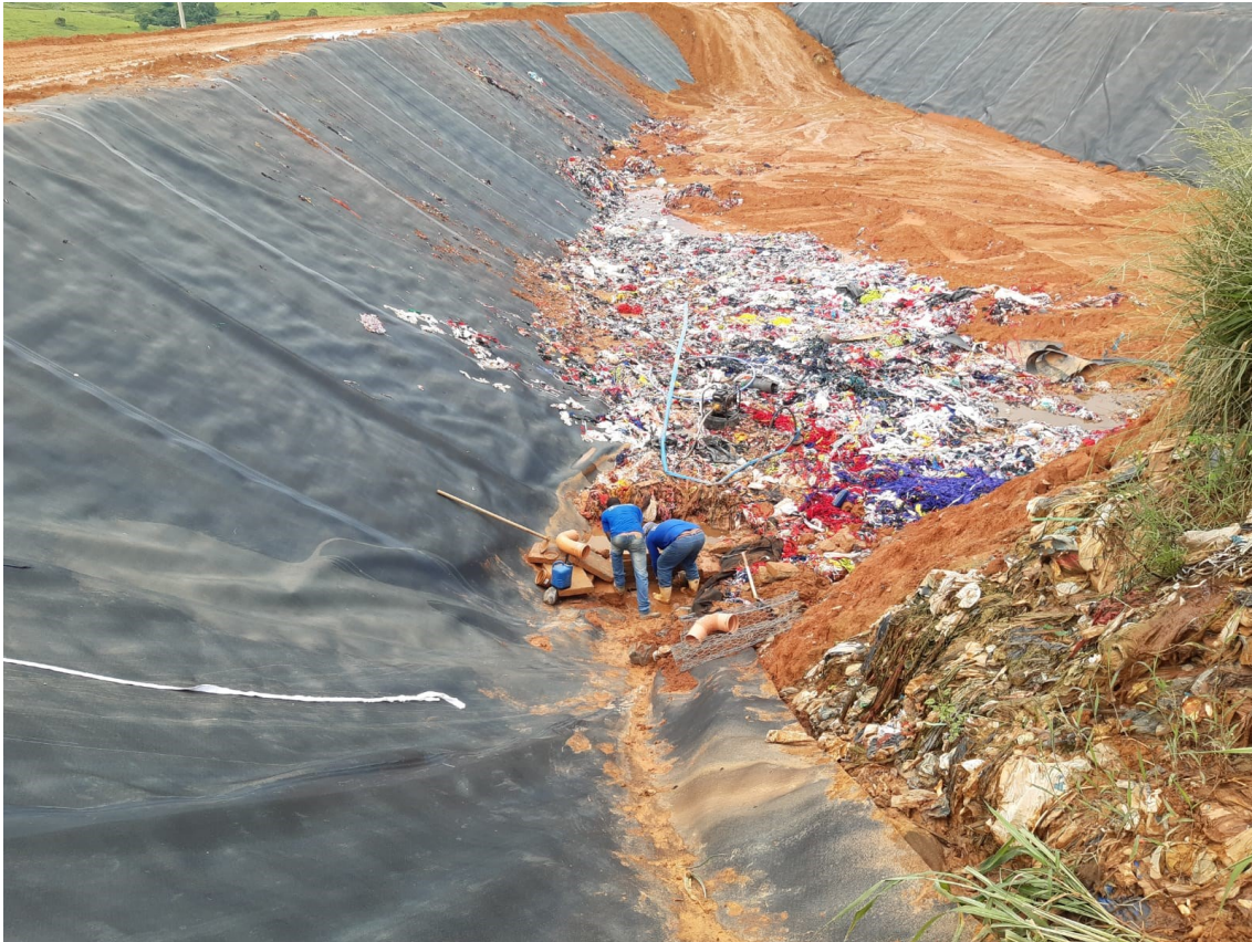
Foto 01: Construção de drenos verticais no aterro sanitário
