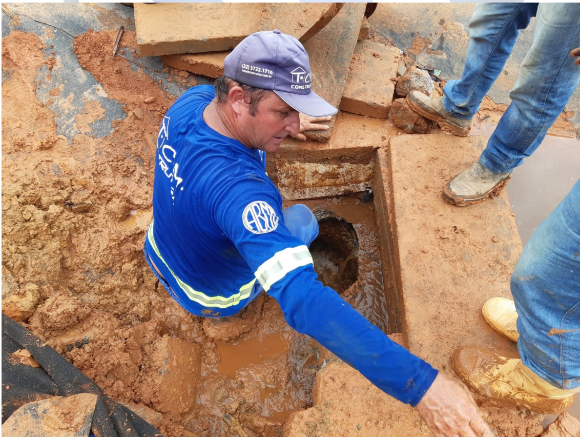
Foto 02: Construção de drenos verticais no aterro sanitário
