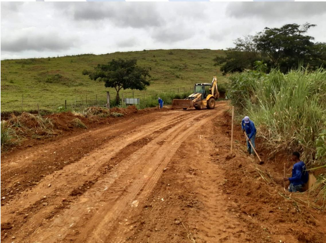
Foto 08: Manutenção do sistema de drenagem pluvial da estrada de acesso ao aterro sanitário
