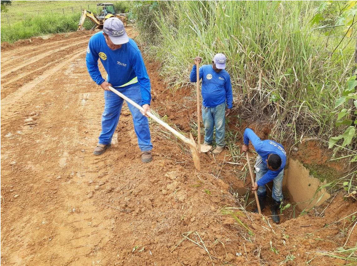
Foto 07: Manutenção do sistema de drenagem pluvial da estrada de acesso ao aterro sanitário
