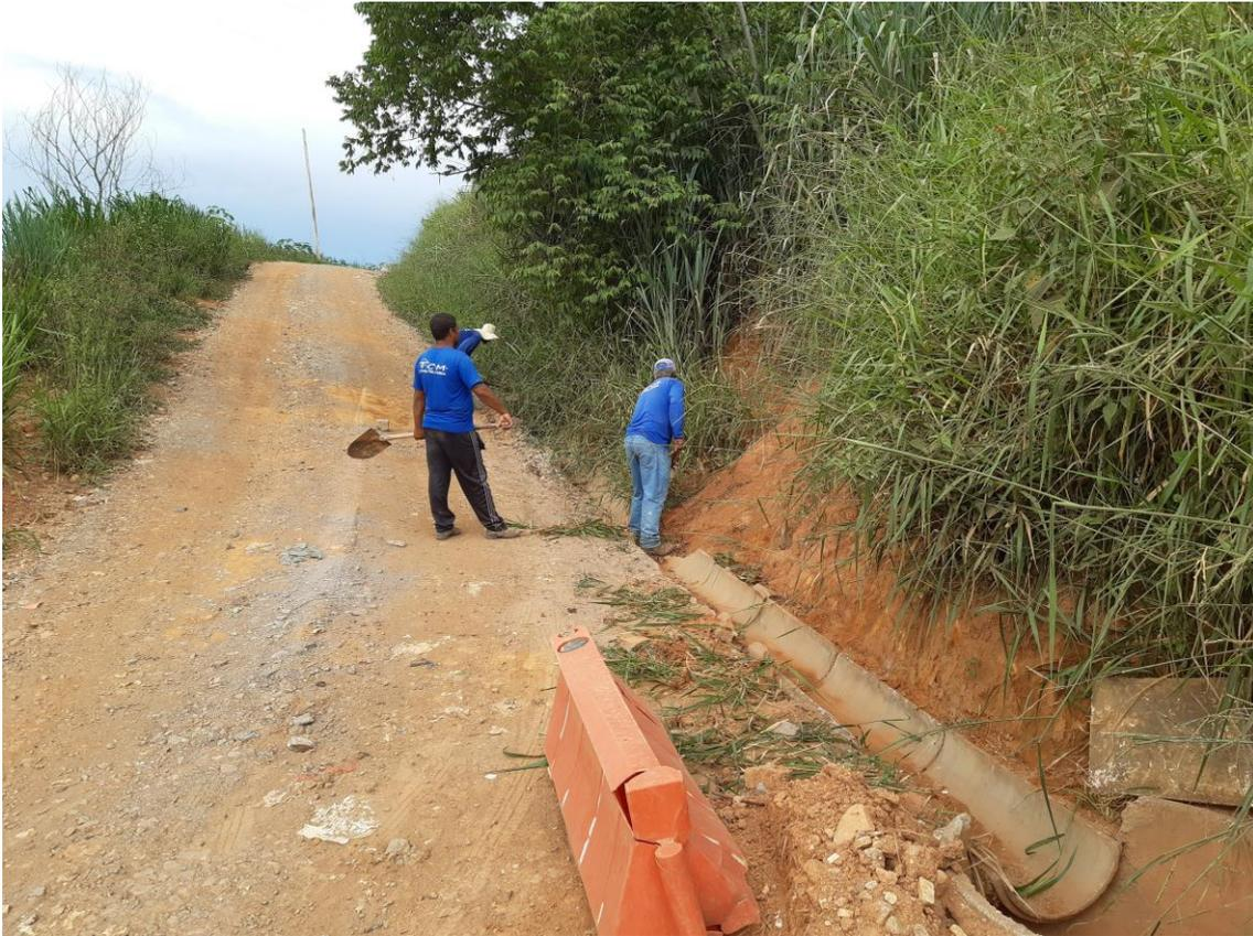
Foto 03: Manutenção do sistema de drenagem pluvial do aterro sanitário
