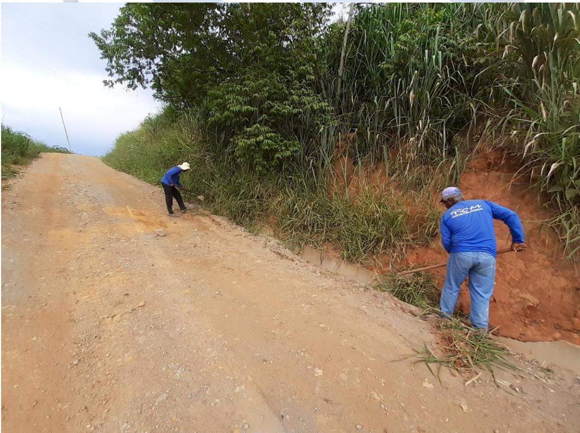
Foto 04: Manutenção do sistema de drenagem pluvial do aterro sanitário
