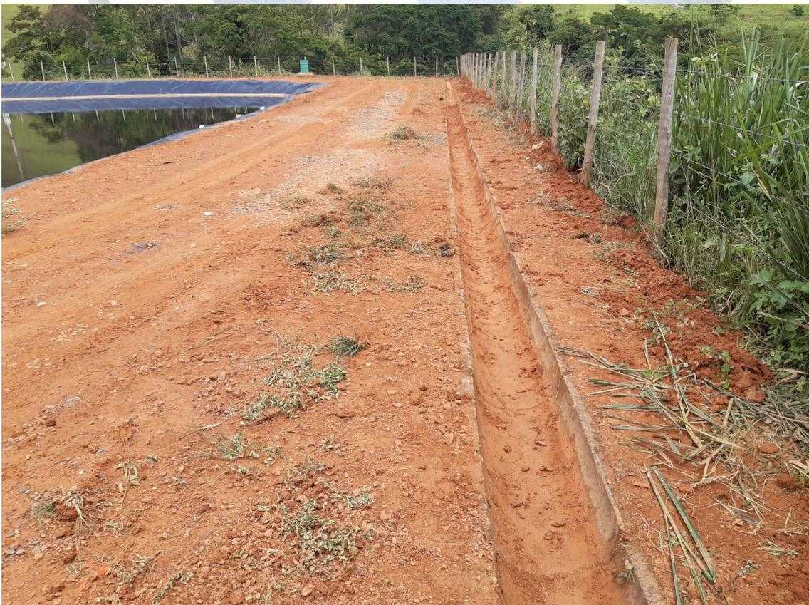
Foto 06: Manutenção do sistema de drenagem pluvial do aterro sanitário
