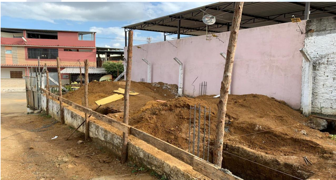
Foto 4: Locação das sapatas de fundação.
