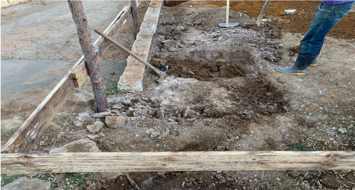
Foto 1: Escavação de fundação tipo sapata.
