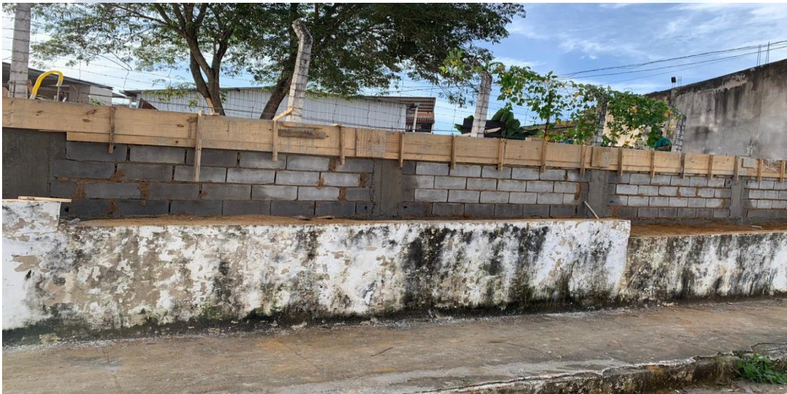
Foto 14: Construção de muro
