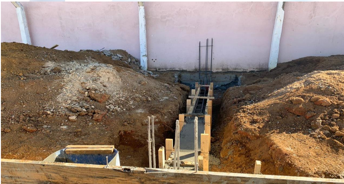
Foto 8: Concretagem das vigas baldrames.
