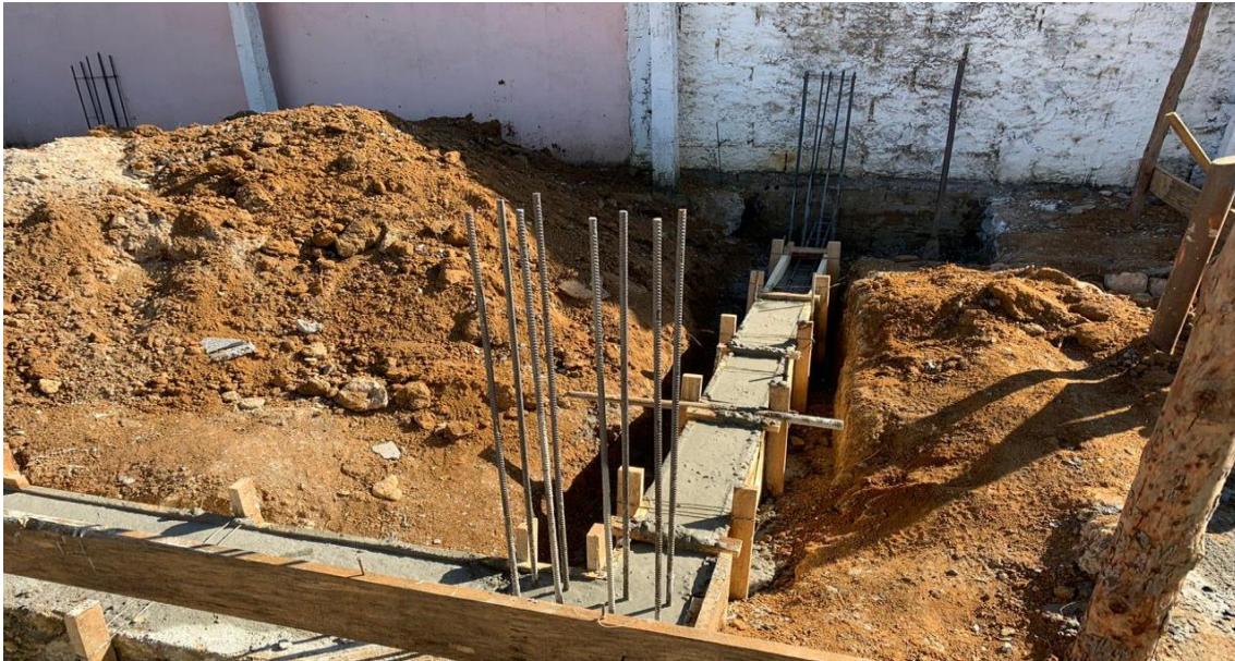
Foto 9: Concretagem das vigas baldrames.
