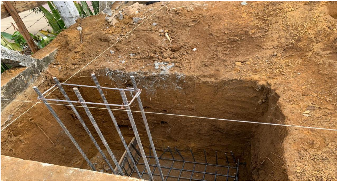
Foto 3: Locação das sapatas de fundação.
