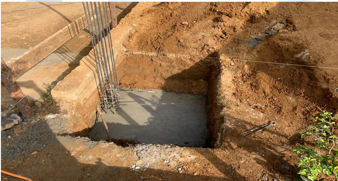
Foto 6: Concretagem das sapatas de fundação.
