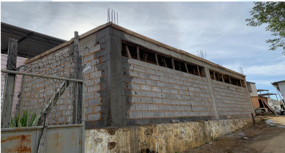
Foto 12: Execução da alvenaria almojarifado.
