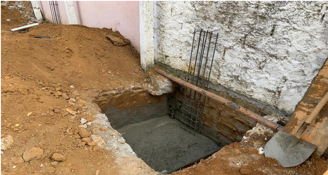
Foto 5: Concretagem das sapatas de fundação.
