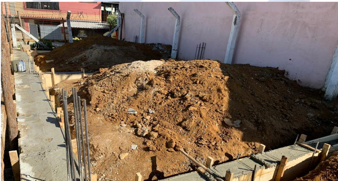
Foto 10: Concretagem das vigas baldrames.
