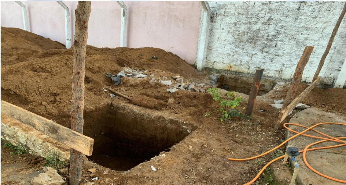
Foto 2: Escavação de fundação tipo sapata.
