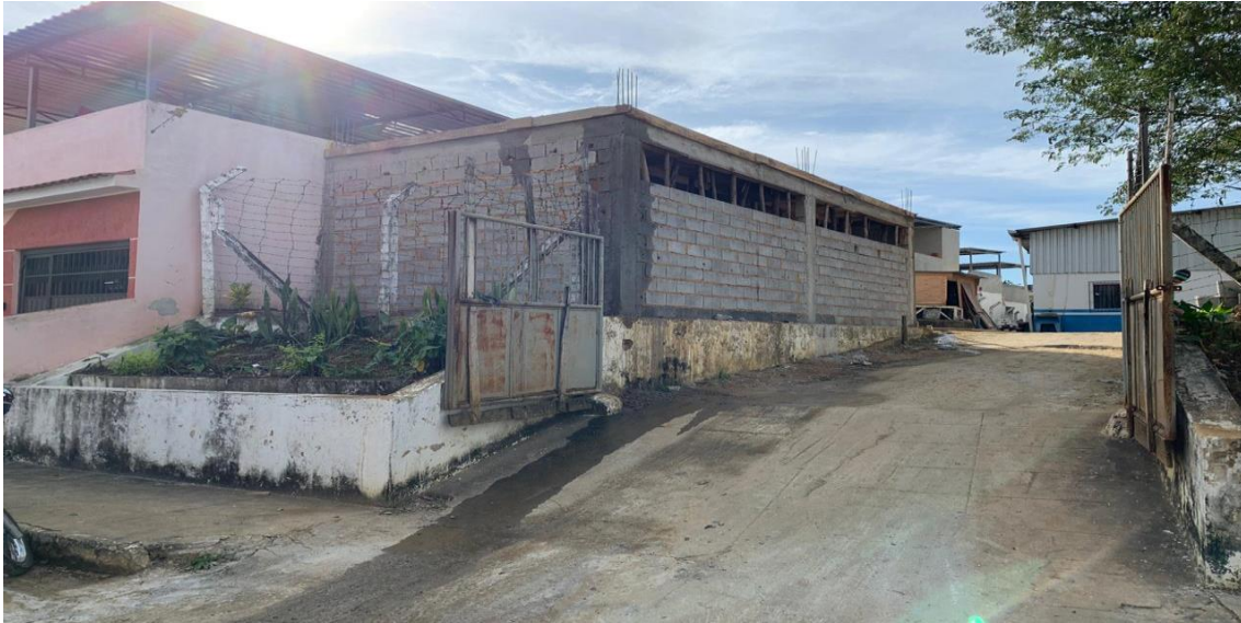
Foto 13: Execução da alvenaria almojarifado.
