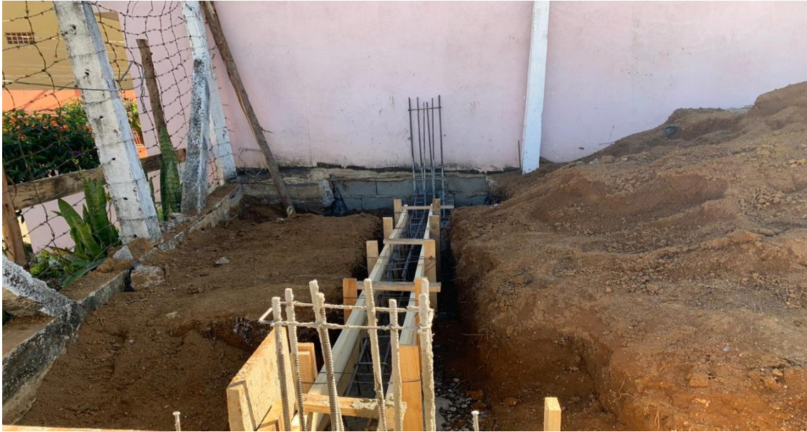
Foto 7: Montagem das caixarias das vigas baldrames.
