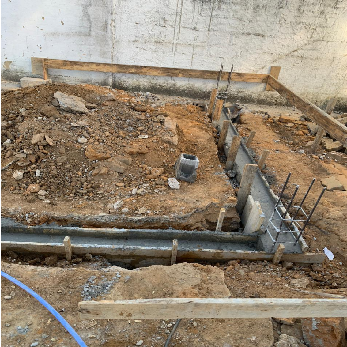
Foto 5: Concretagem vigas baldrame do estacionamento.
