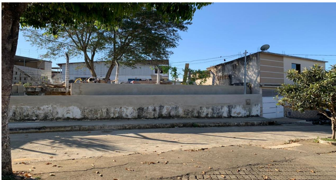
Foto 4: Emboço das alvenarias do Almojarifado.
