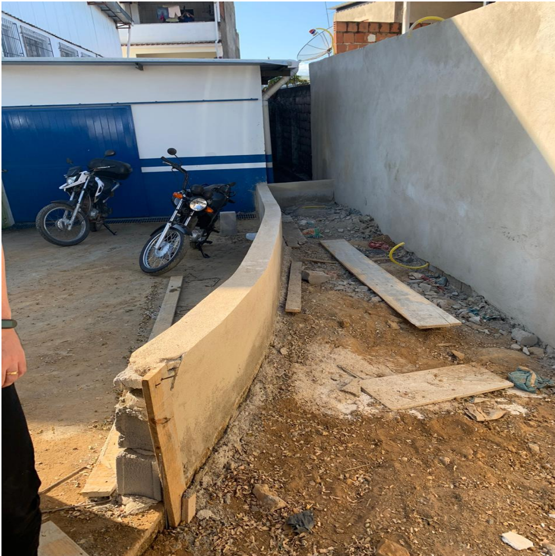
Foto 2: Construção de muro de divisa e emboço.
