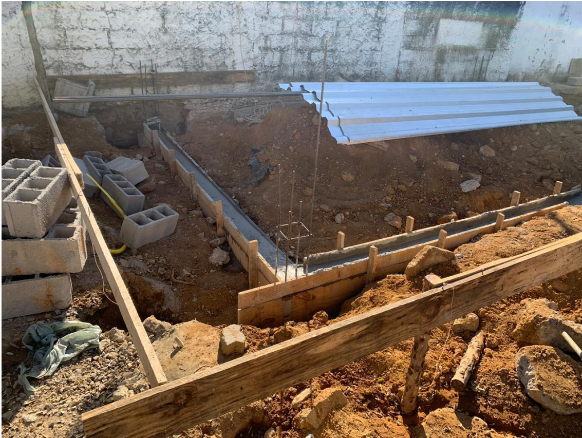
Foto 6: Concretagem vigas baldrame do estacionamento.
