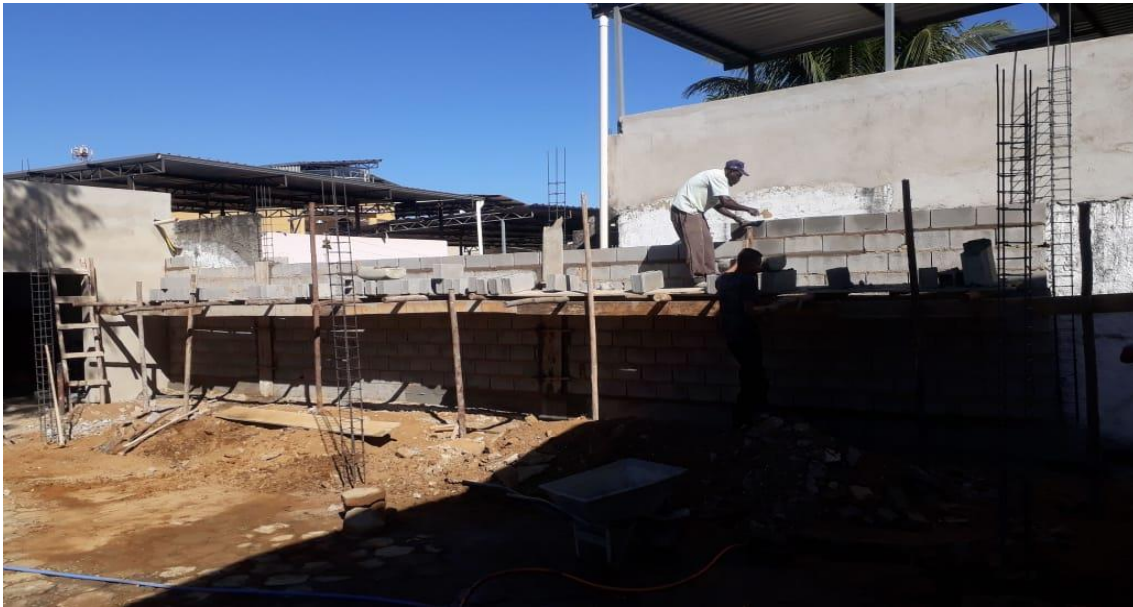
Foto 8: Construção muro de divisa do estacionamento.
