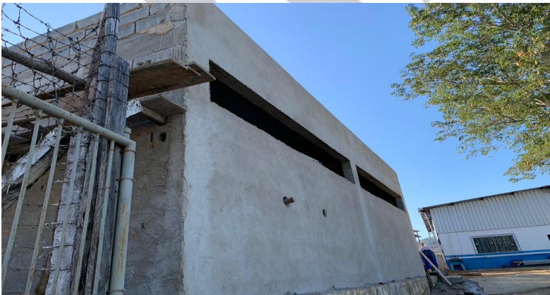
Foto 7: Emboço das alvenarias do Almoxarifado.
