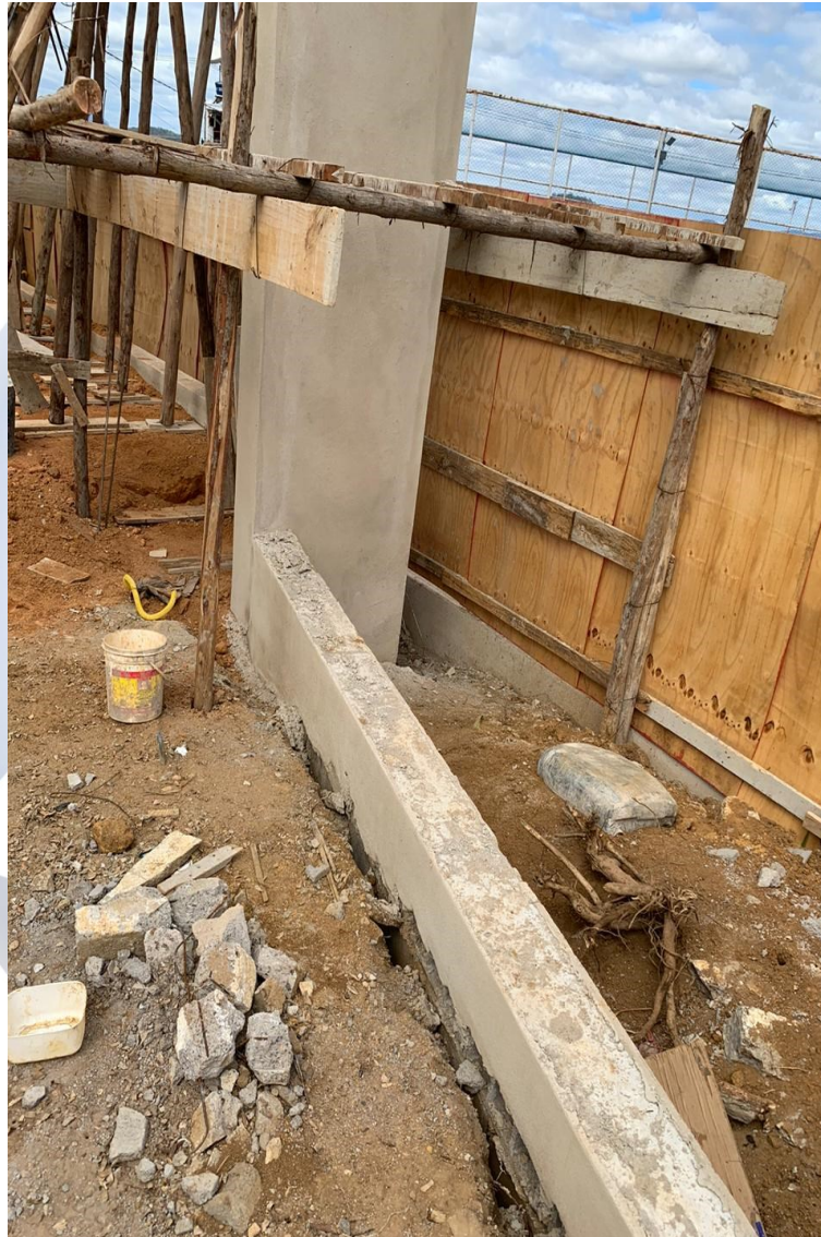
Foto 10: Pilar de apoio para o brise concretado e emboçado.
