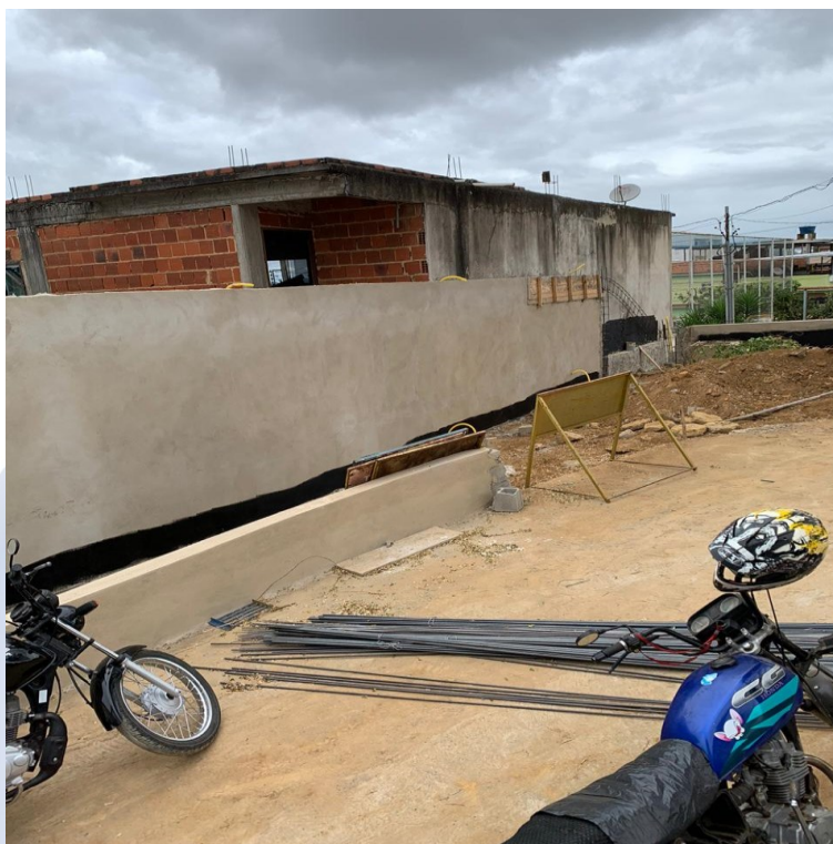
Foto 11: Muro de divisa emboçado e impermeabilizado.
