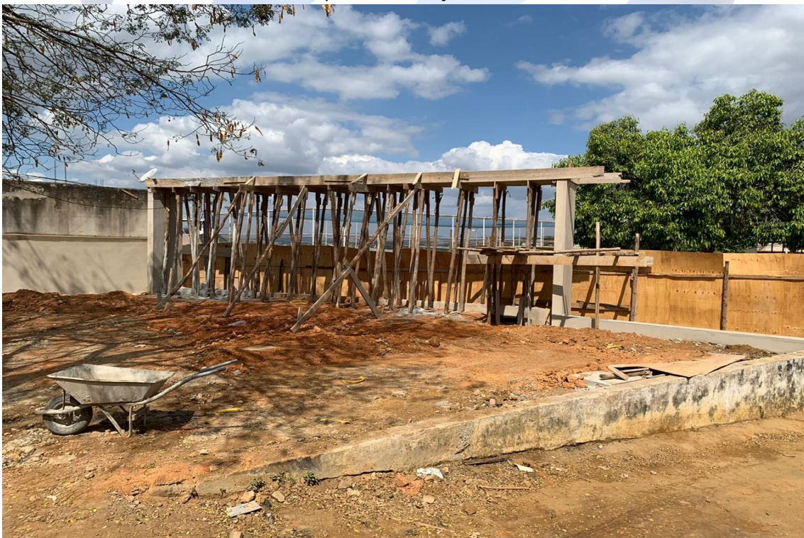
Foto 9: Estrutura concretada para sustentação de brise de estrutura metálica.
