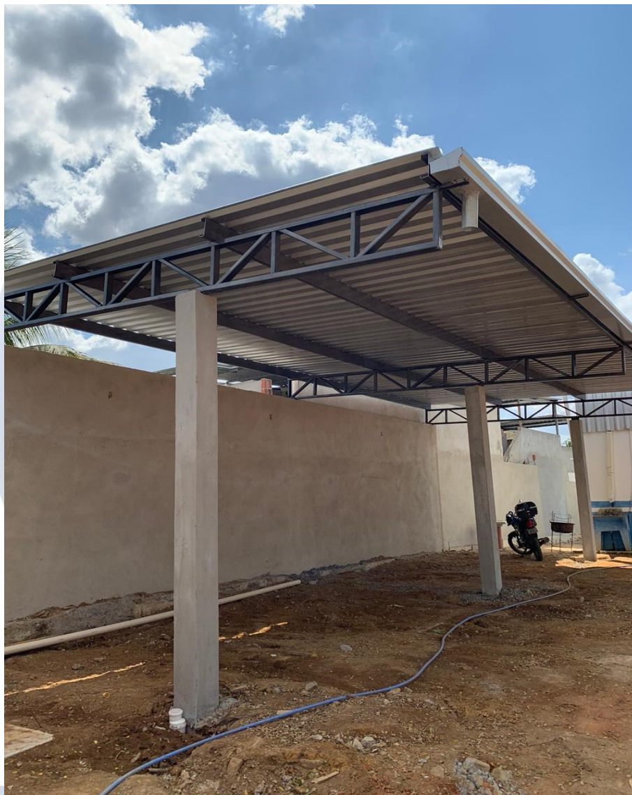
Foto 2: Cobertura metálica do estacionamento instalada.
