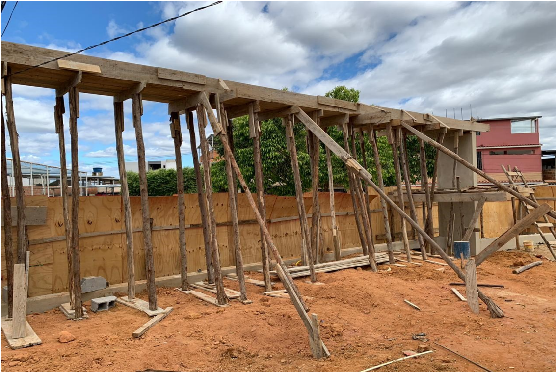
Foto 8: Estrutura concretada para sustentação de brise de estrutura metálica.
