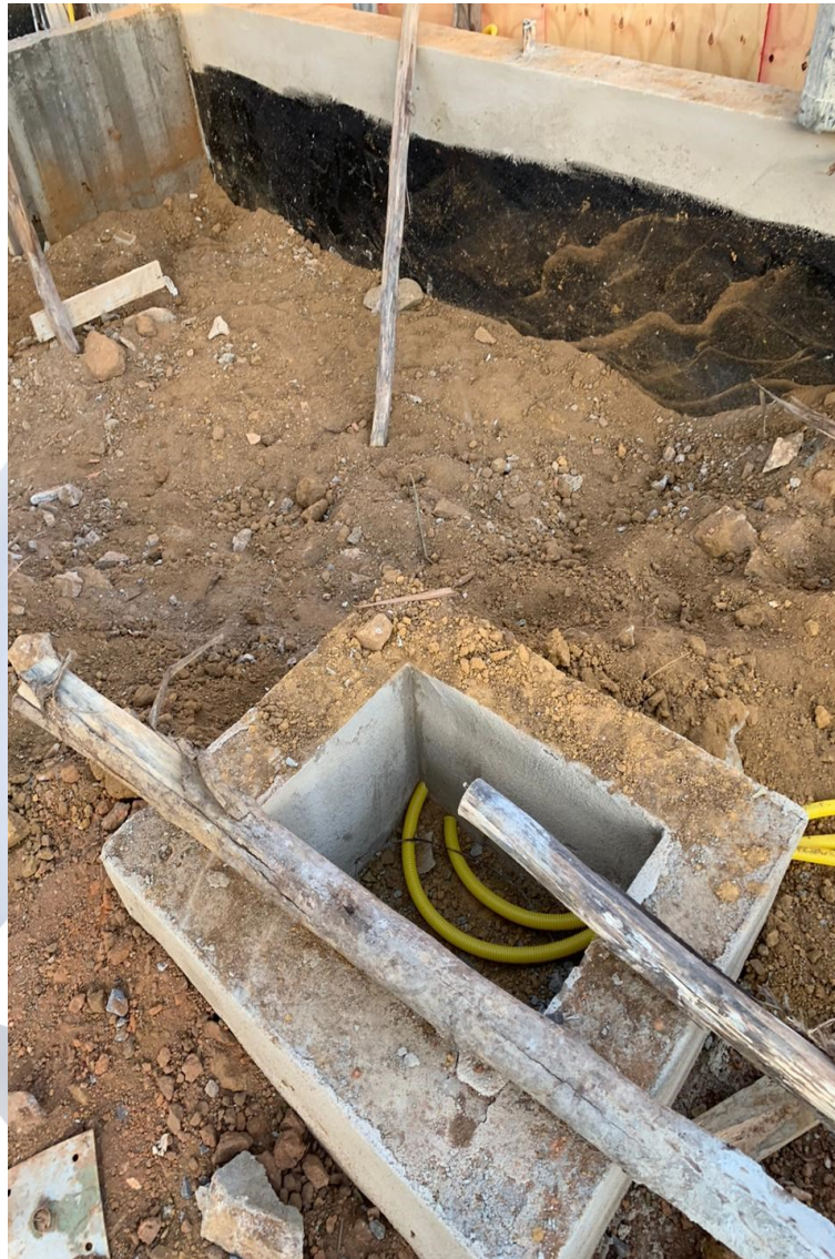
Foto 11: Montagem da caixa de passagem.
