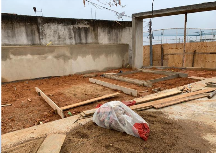
Foto 7: Concretagem da base e instalação do conjunto de mesa de concreto para jogos.
