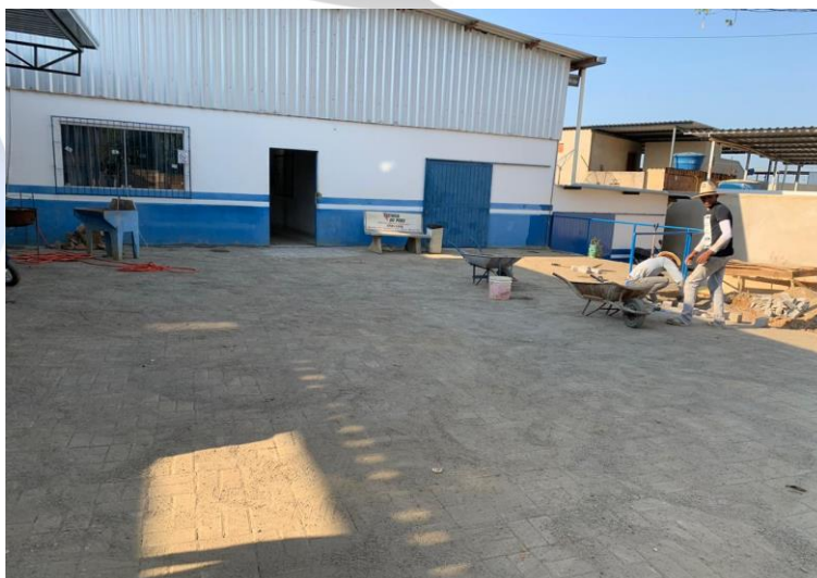
Foto 11: Execução de pátio em piso intertravado, com bloco retangular de 20 x 10cm.
