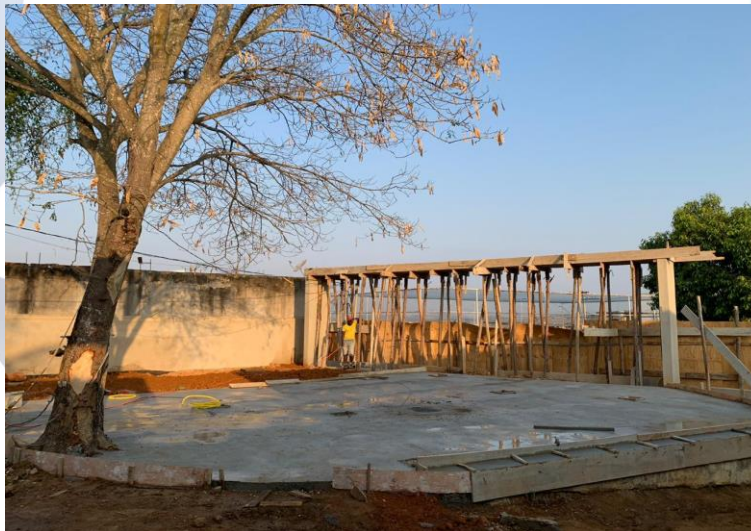
Foto 5: Piso concretado, espessura 10 cm, armado.
