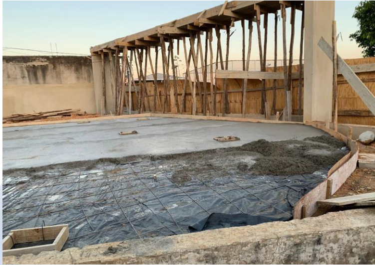
Foto 4: Piso concretado, espessura 10 cm, armado.
