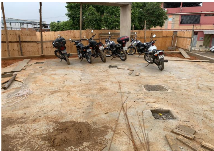
Foto 5: Piso concretado, espessura 10 cm, armado.
