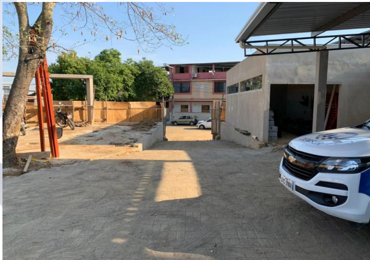
Foto 11: Execução de pátio em piso intertravado, com bloco retangular de 20 x 10cm.
