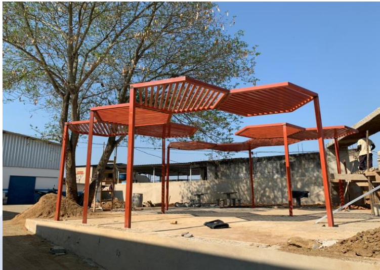
Foto 11: Instalação de estrutura metálica, cobertura da área de convivência.
