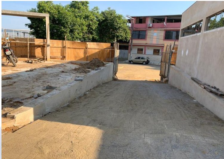
Foto 10: Execução de pátio em piso intertravado, com bloco retangular de 20 x 10cm.
