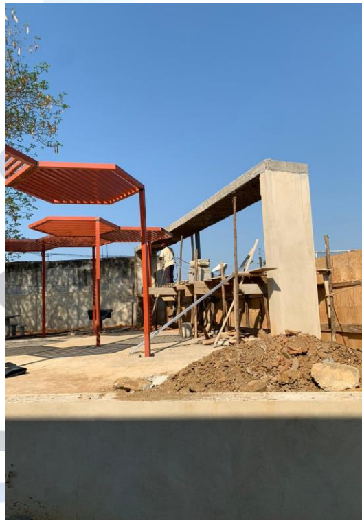
Foto 12: Instalação de estrutura metálica, cobertura da área de convivência.
