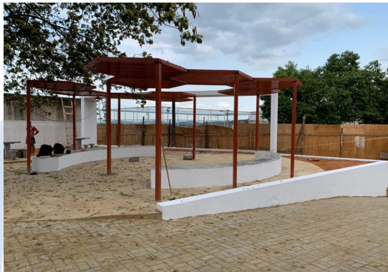
Foto 1: Estrutura metálica, cobertura da área de convivência instalada.
