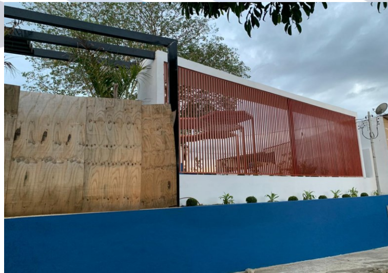
Foto 13: Facha principal, instalação de brise, pintura e paisagismo.
