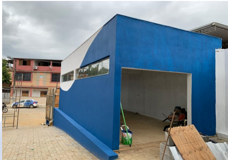
Foto 4: Pintura das paredes externas do almoxarifado.
