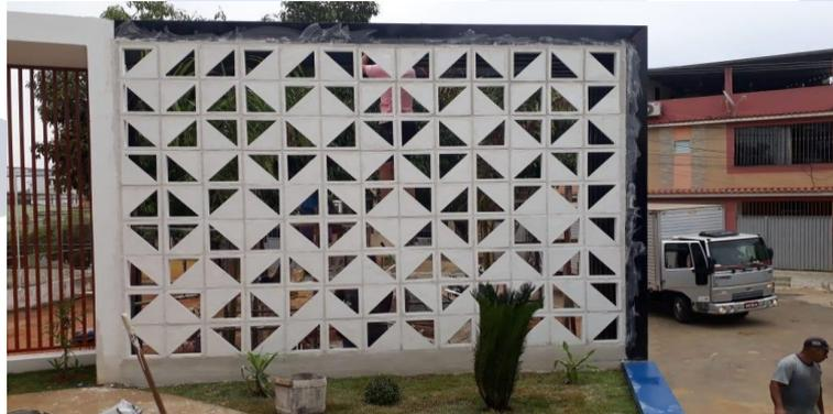
Foto 10: Cobogós instalados e pintura concluída na área de convivência.
