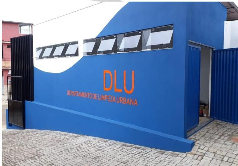
Foto 6: Pintura da fachada, instalação de logo do Demsur e instalação dos letreiros em ACM.
