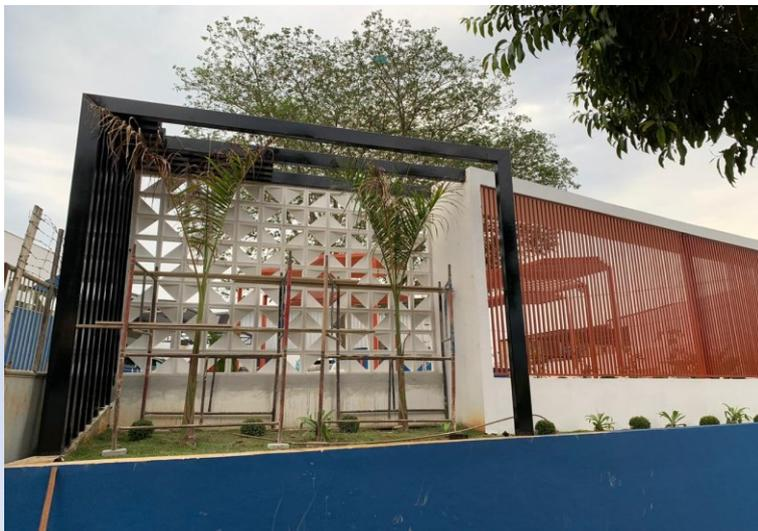
Foto 2: Instalação dos pergolados em estrutura metálica e instalação de brise.
