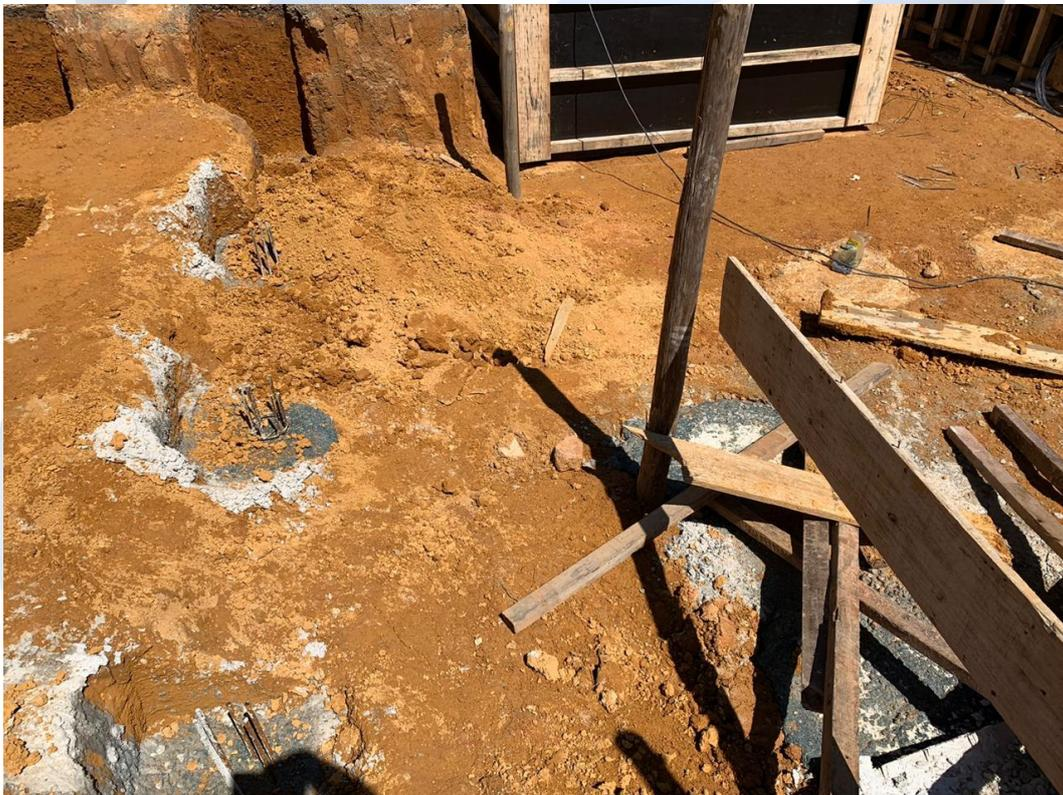
Foto 7: Utilização de concreto e ferragens nas fundações.
