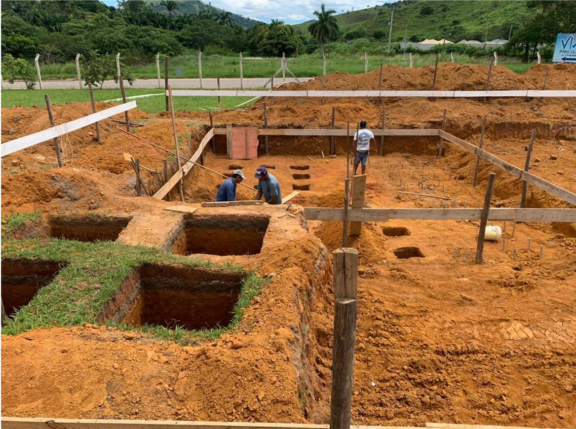
Foto 6: Escavação realizada para fundação da base dos Filtros e Calha Parshall.
