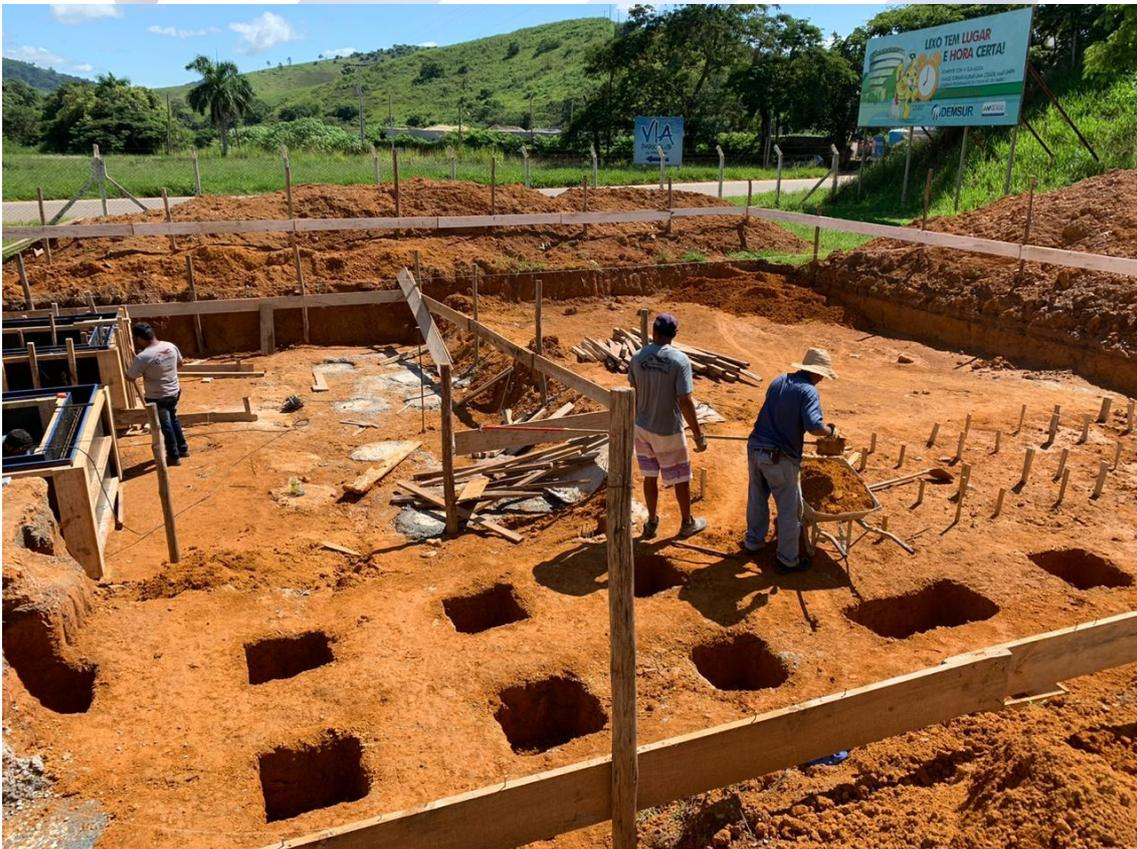
Foto 5: Escavação realizada para fundação da base dos Floculadores.
