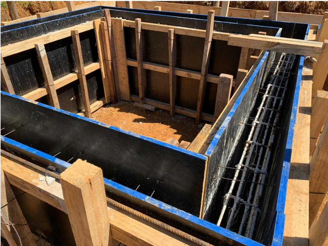
Foto 8: Fôrmas e Armaduras pré-concretagem da base de um Filtro.
