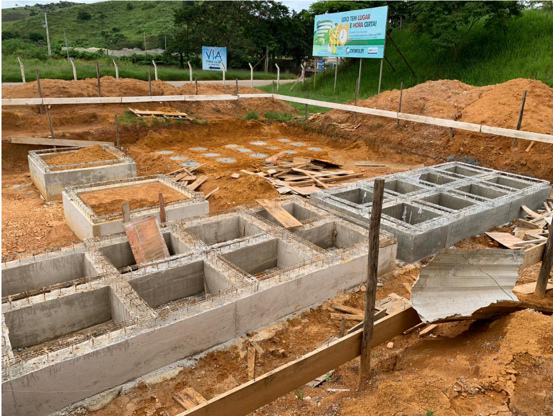
Foto 3 – Início da armação das ferragens para a laje das bases dos floculadores.
