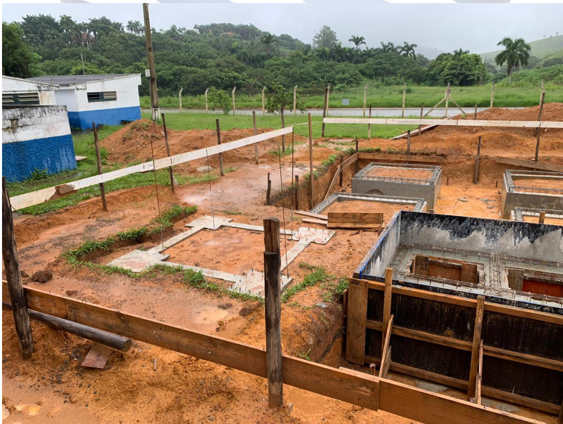
Foto 2: Concretagem da base da Calha Parshall.
