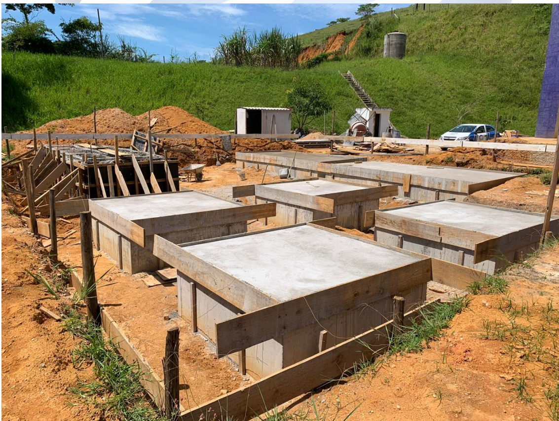
Foto 6 - Concretagem das lajes das bases dos floculadores e filtros.
