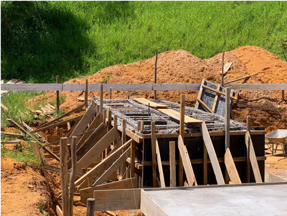
Foto 7 – Fôrmas para concretagem da base de um dos decantadores.
