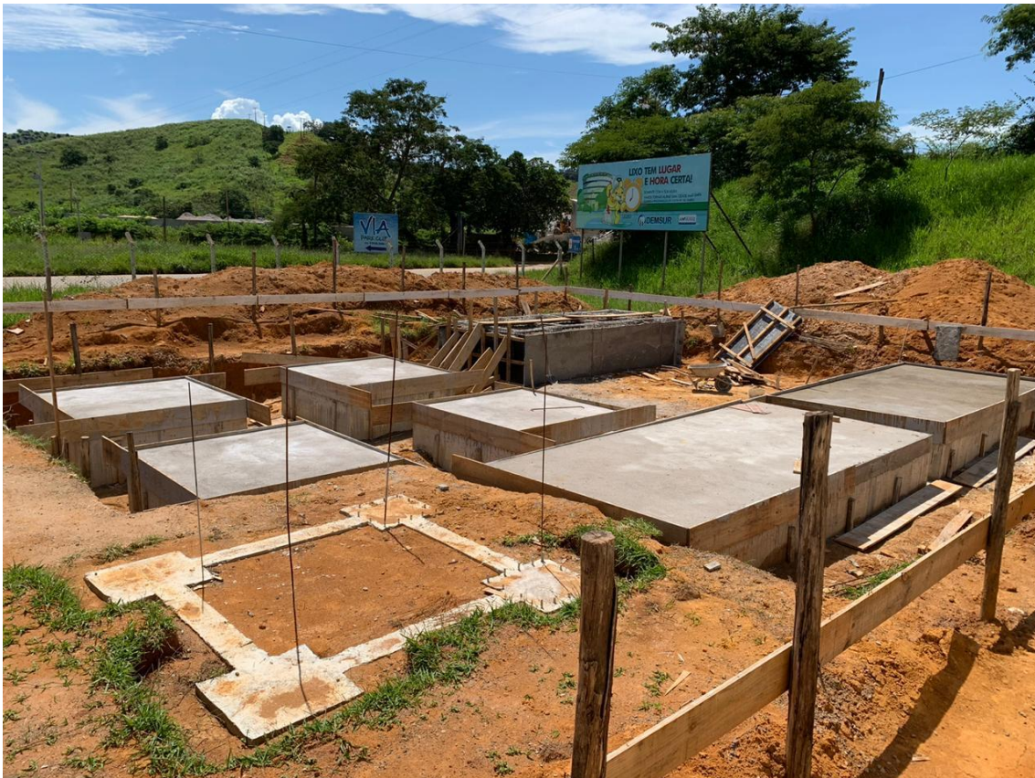
Foto 5 - Concretagem das lajes das bases dos floculadores e filtros.
