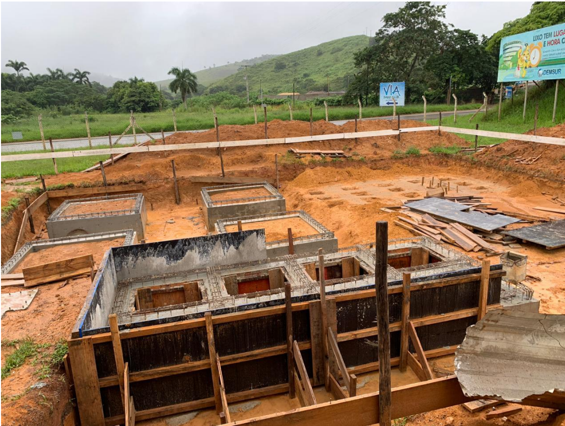
Foto 1: Fôrma da base dos Floculadores.
