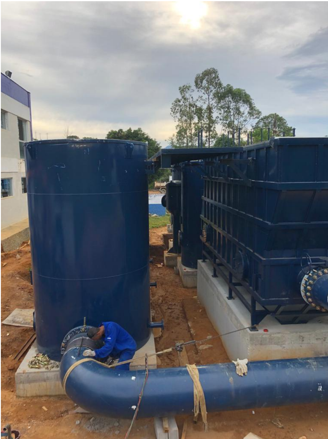
Foto 3: Nova ETA sendo instalada em bases totalmente concretadas e curadas.
