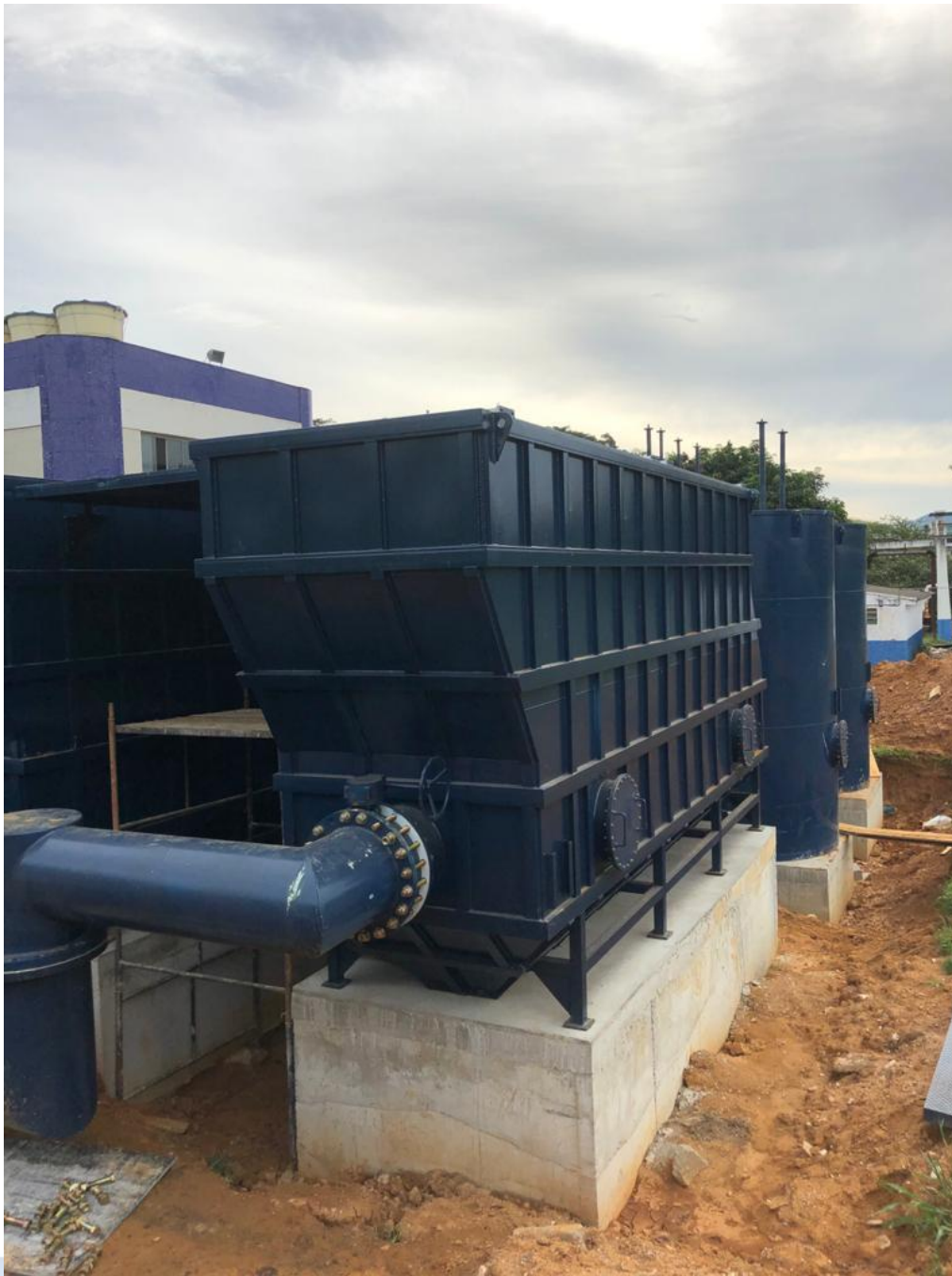
Foto 4: Nova ETA sendo instalada em bases totalmente concretadas e curadas.
