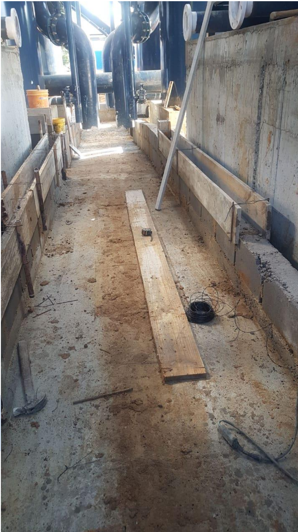
Foto 6: Solo concretado e início de execução da canaleta.
