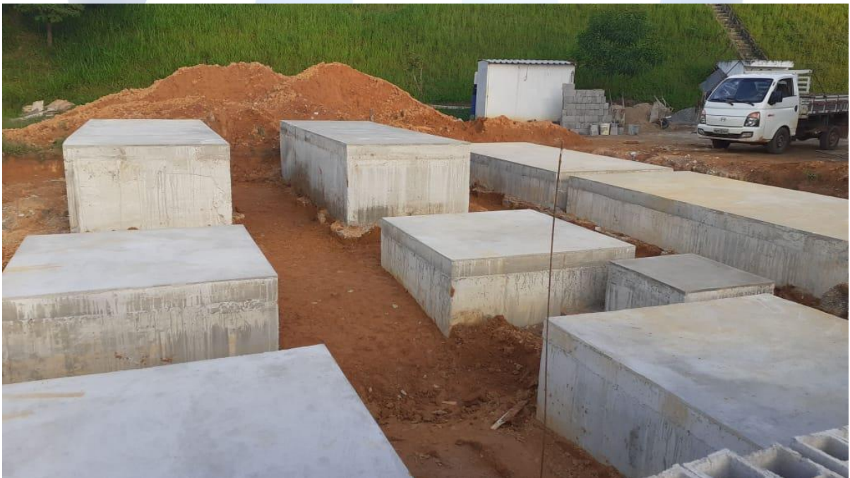
Foto 2: Bases sendo totalmente finalizadas e aptas a receber a Nova ETA Rio Preto.
