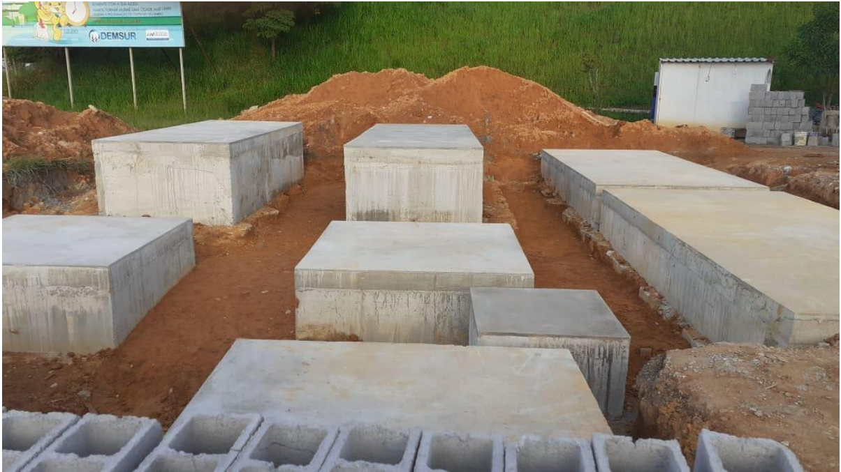
Foto 1: Bases sendo totalmente finalizadas e aptas a receber a Nova ETA Rio Preto.
