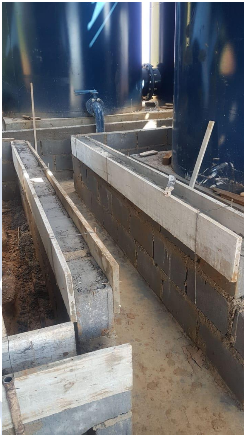
Foto 7: Construção da canaleta.
