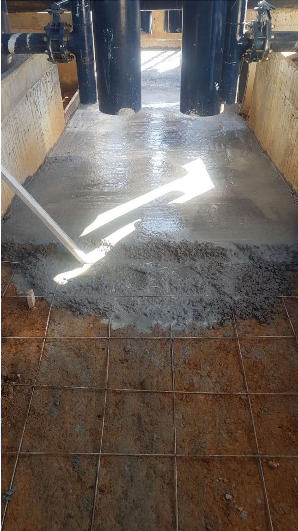
Foto 5: Início da concretagem do solo.
