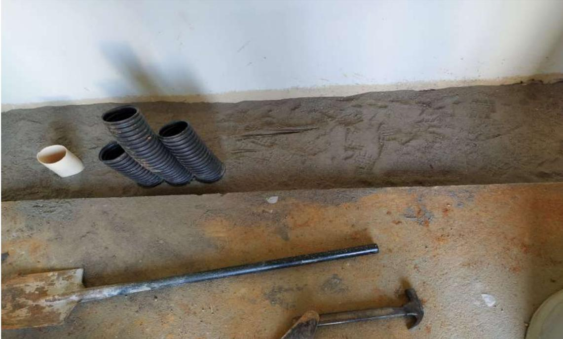
Foto 15 – Saída dos cabos elétricos dos transformadores para tubulação de distribuição.
