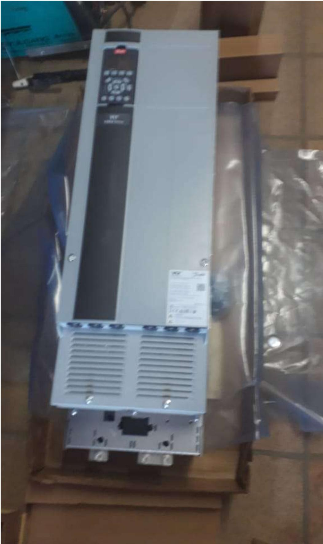
Foto 22 – Inversor de frequência para acionamento das bombas.
