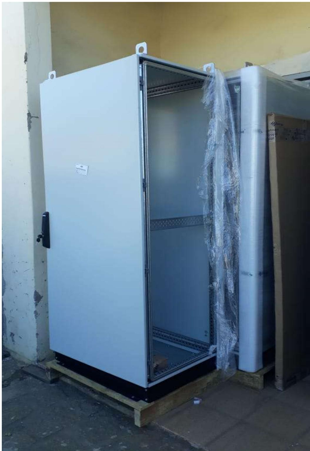
Foto 18 - Recebimento dos quadros TTA responsável por acomodar componentes elétricos / eletrônicos das bombas de 40 cv e 200 cv.
