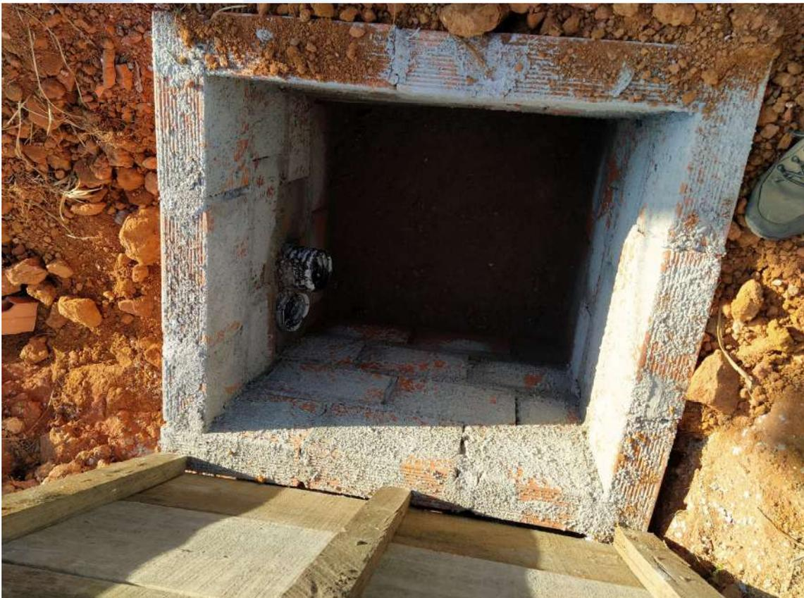
Foto 16 - Caixa de passagem dos cabos elétricos.
