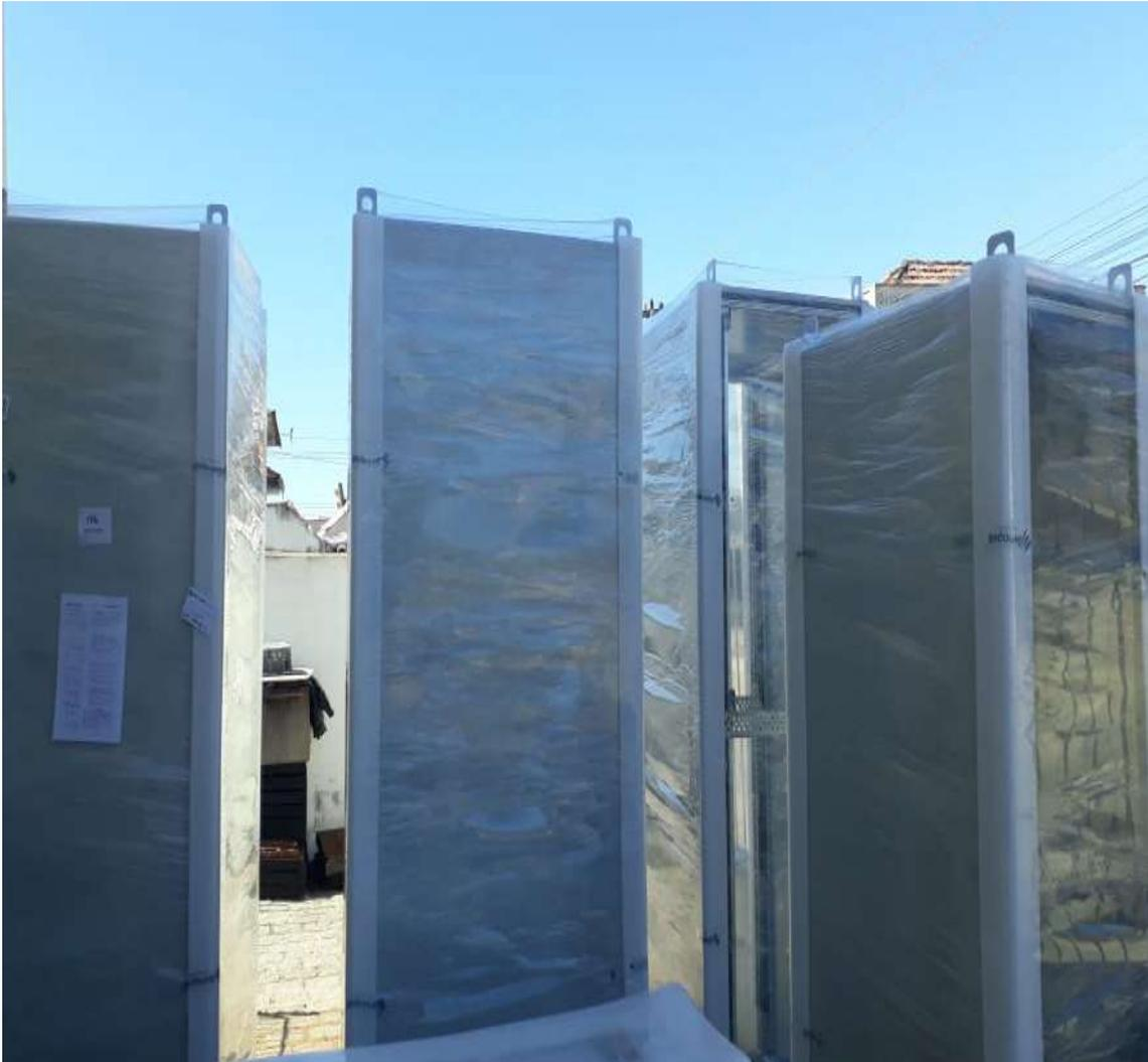
Foto 17 – Recebimento dos quadros TTA responsável por acomodar componentes elétricos / eletrônicos das bombas de 40 cv e 200 cv.
