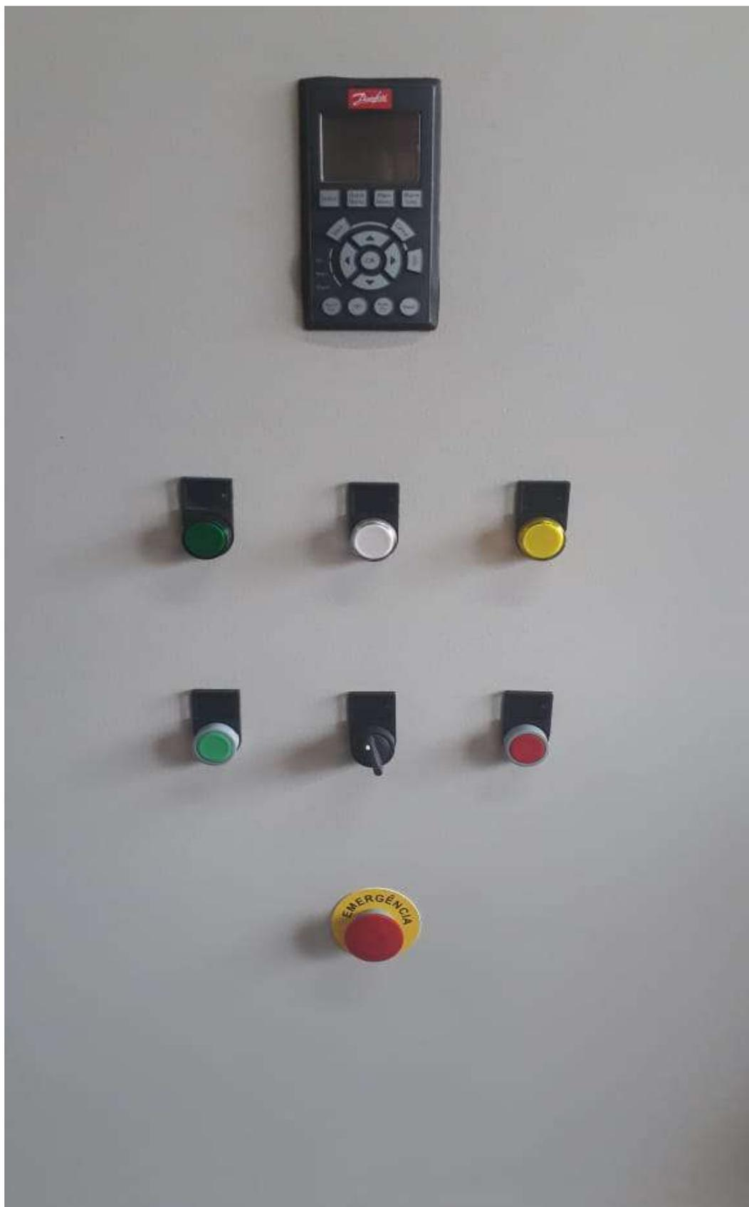
Foto 21 – Layout da frente dos quadros responsável pelo acionamento da bomba de 200 Cv.
