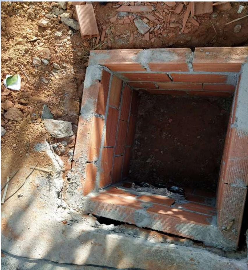
Foto 14 - Caixa de passagem dos cabos elétricos.
