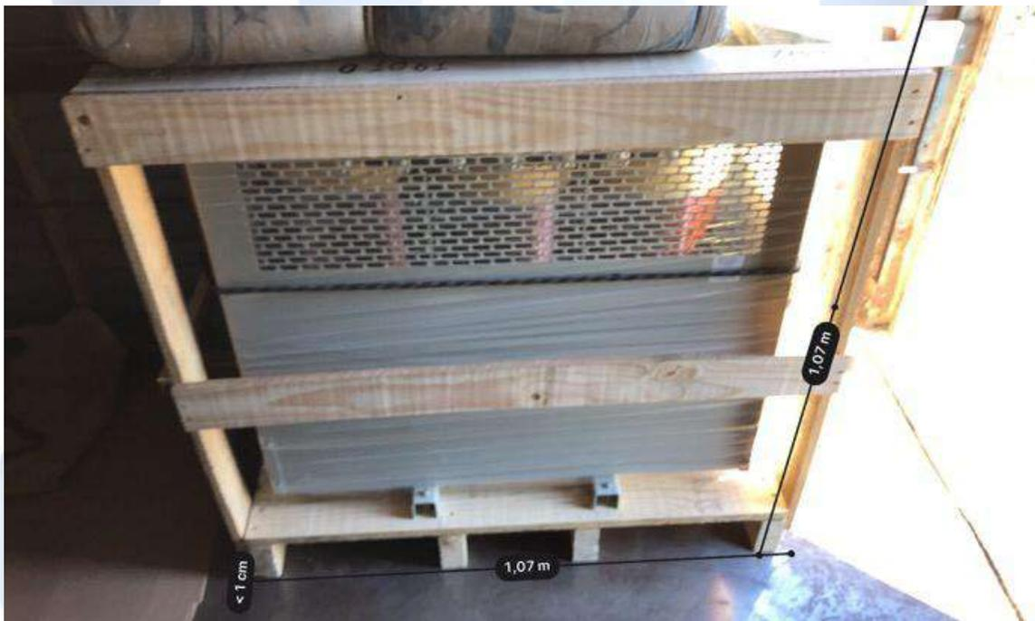
Foto 03 – Transformador baixa/baixa 440 V para 220 / 127 V.
