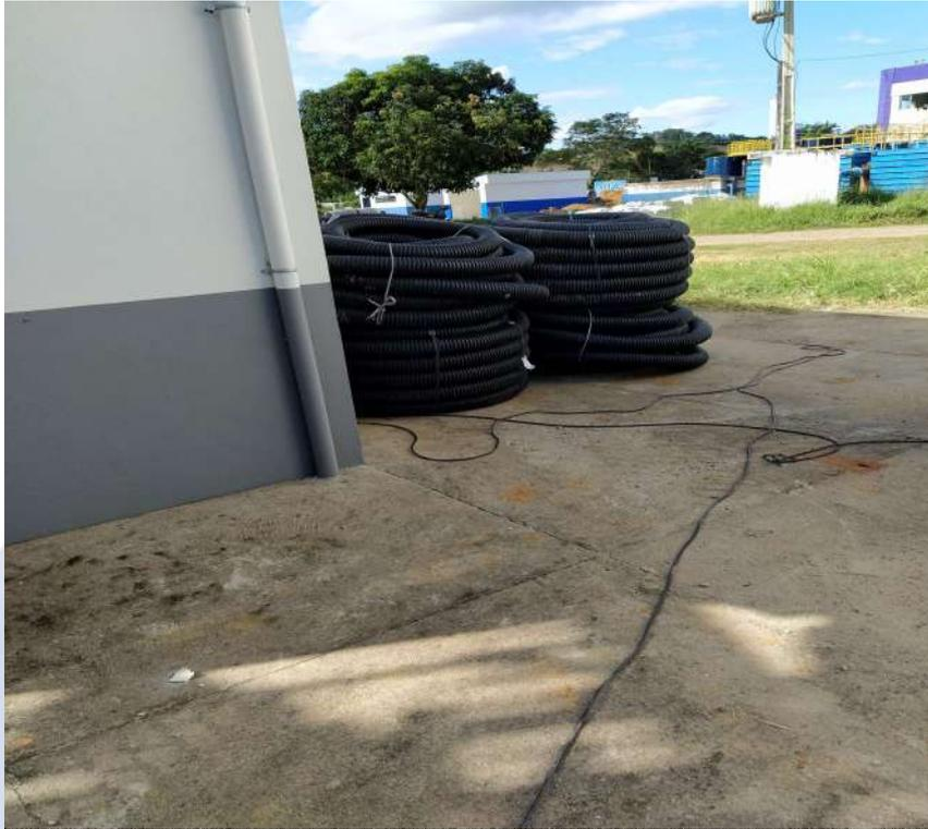
Foto 02 – Eletroduto corrugado para passagem dos cabos elétricos.
