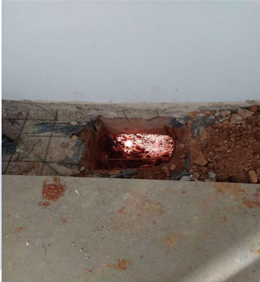
Foto 06 – Início da preparação para saída de energia dos transformadores de 500 KVA.
