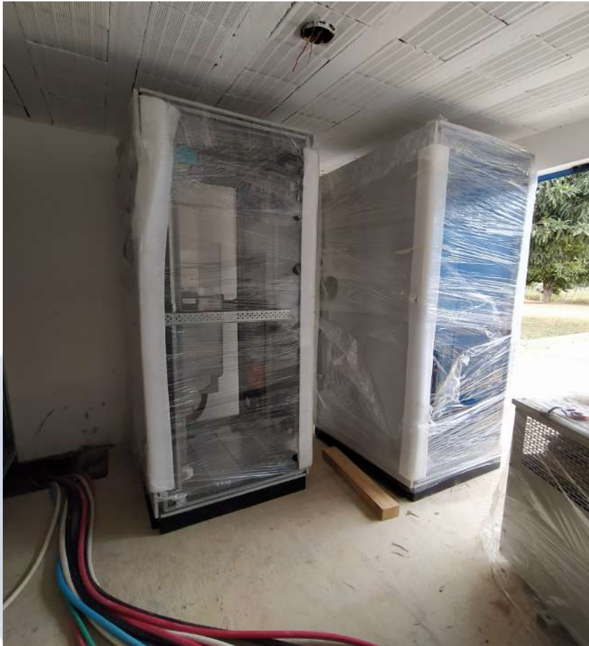
Foto 17 – Quadros de comando sendo montados no local definitivo.
