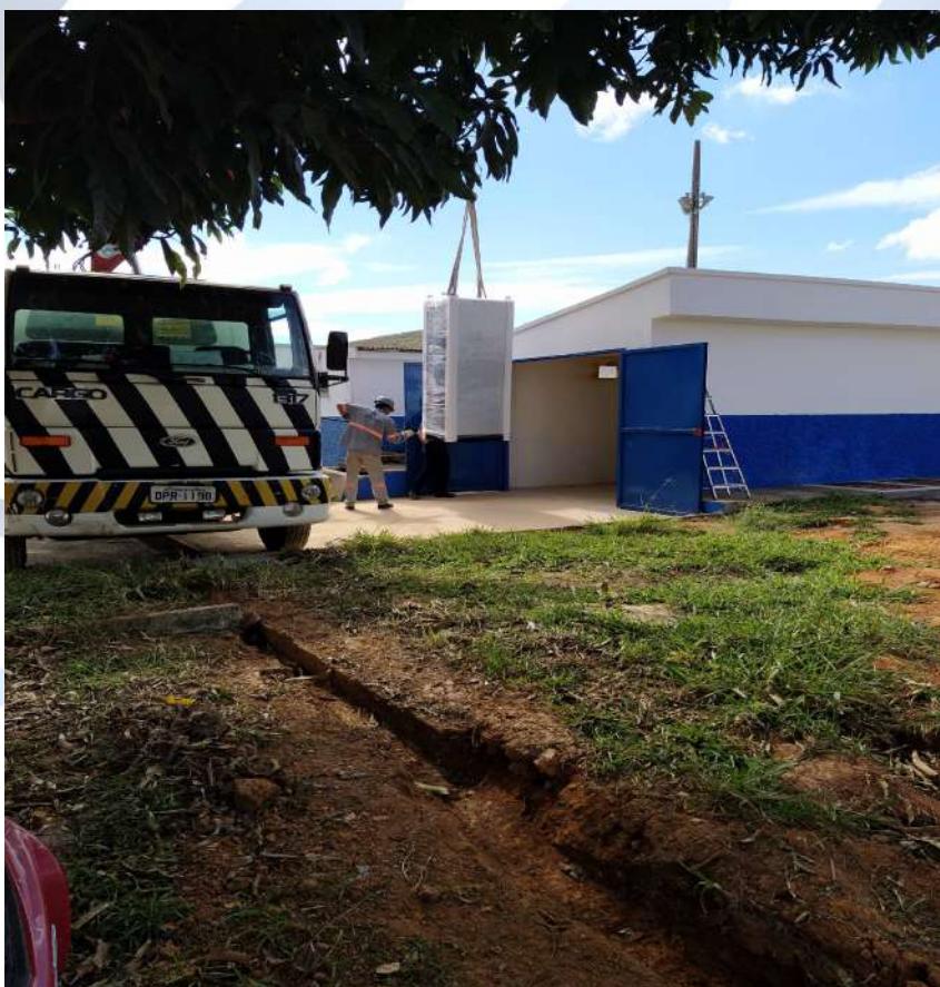
Foto 04 – Descarregamento dos transformadores e quadros.
