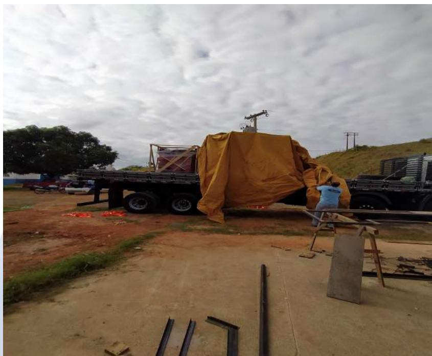
Foto 01 – Descarregamento dos transformadores e quadros.
