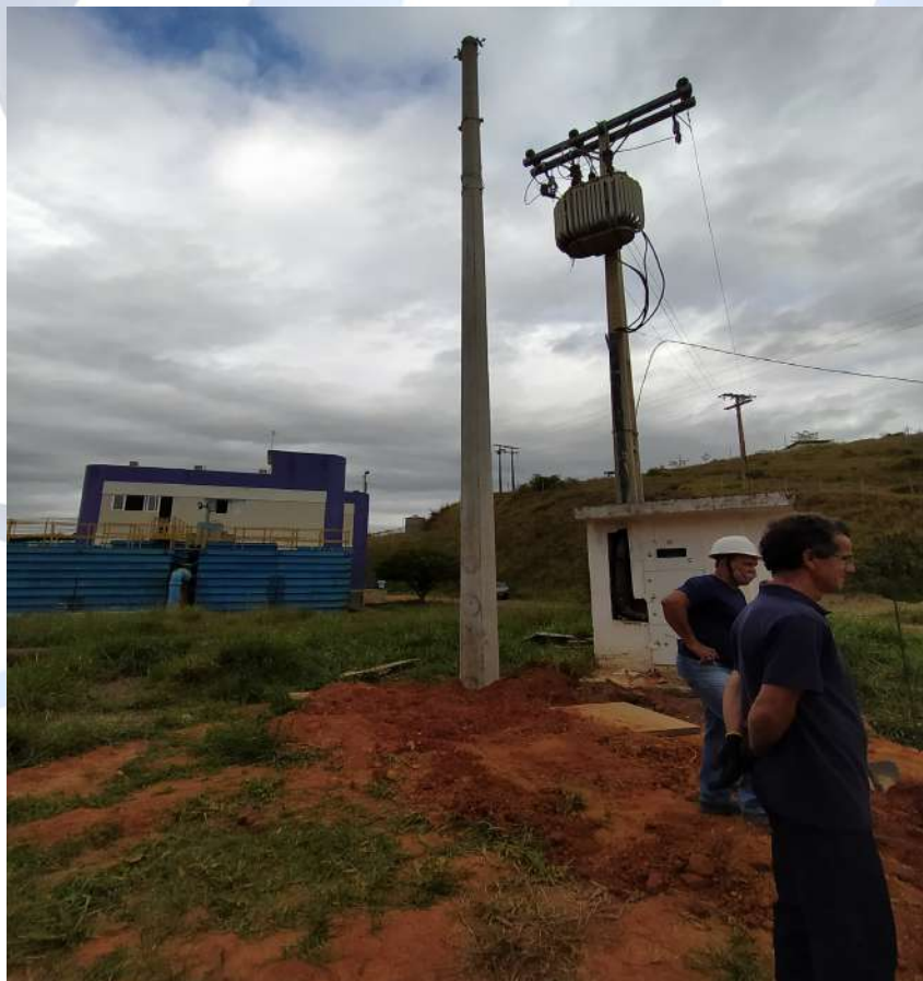
Foto 08 – Instalação do poste do novo trajeto da media tensão.
