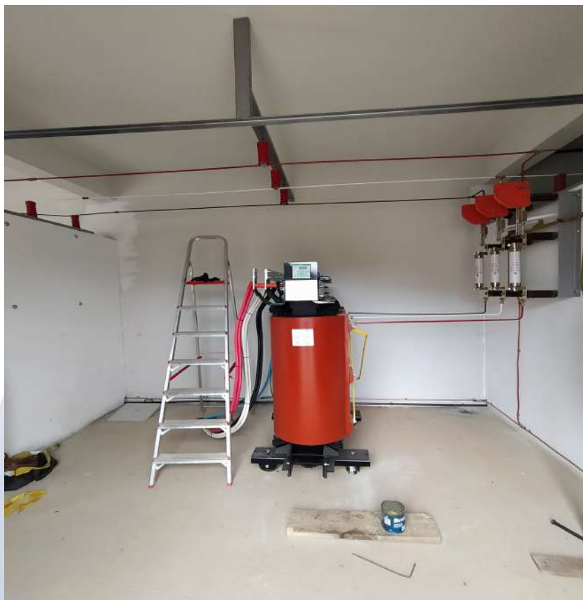
Foto 16 – Instalação das grades de isolamento.
