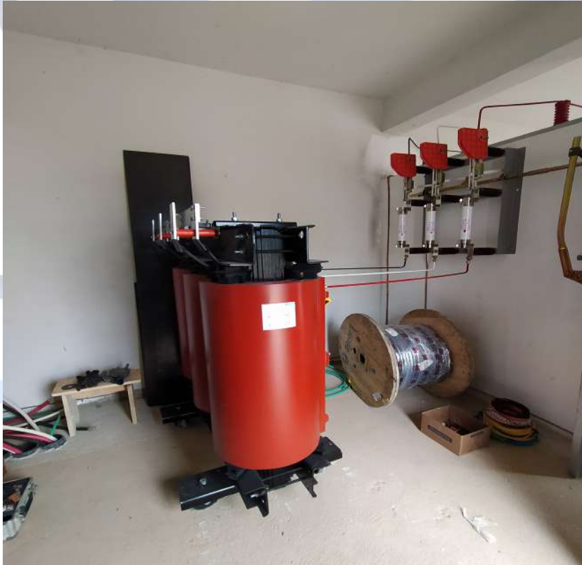
Foto 10 – Transformador 02 instalado
