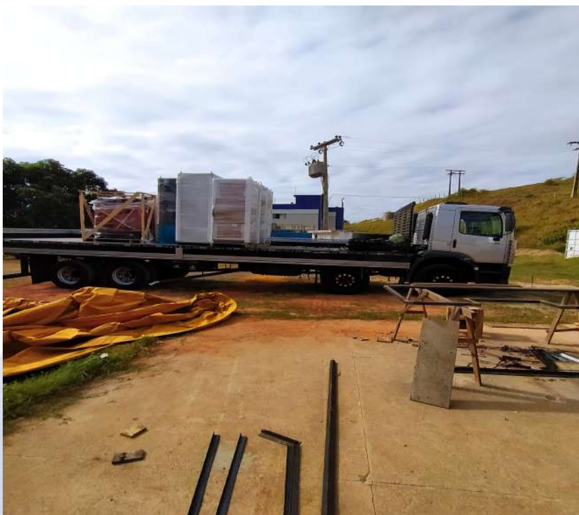
Foto 03 – Descarregamento dos transformadores e quadros.
