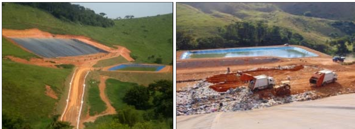
Figuras 1.1 e 1.2. Vista panorâmica do Aterro Sanitário de Muriaé.
