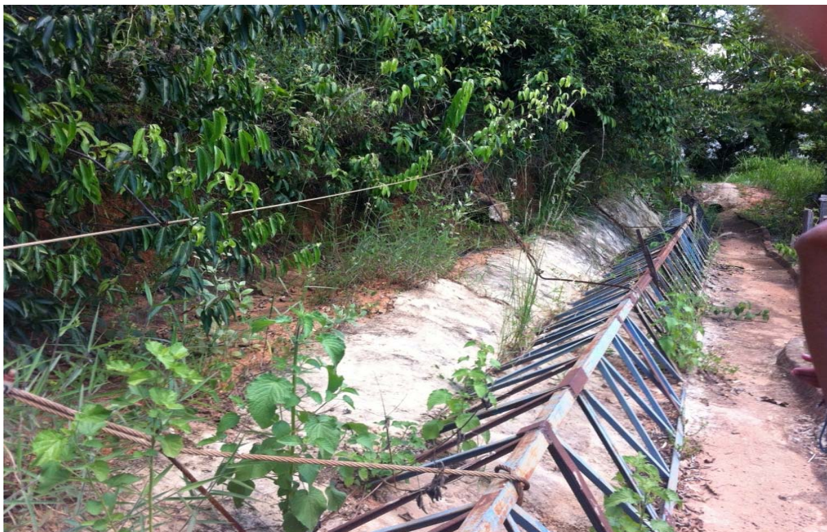
Figura 2.74:Viga de ferro para contenção de encostas ao entorno do manancial do Rio Glória.
