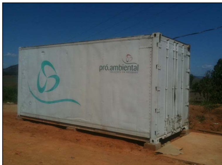
Figura 2.103. Câmara fria para acondicionamento dos resíduos da saúde.
