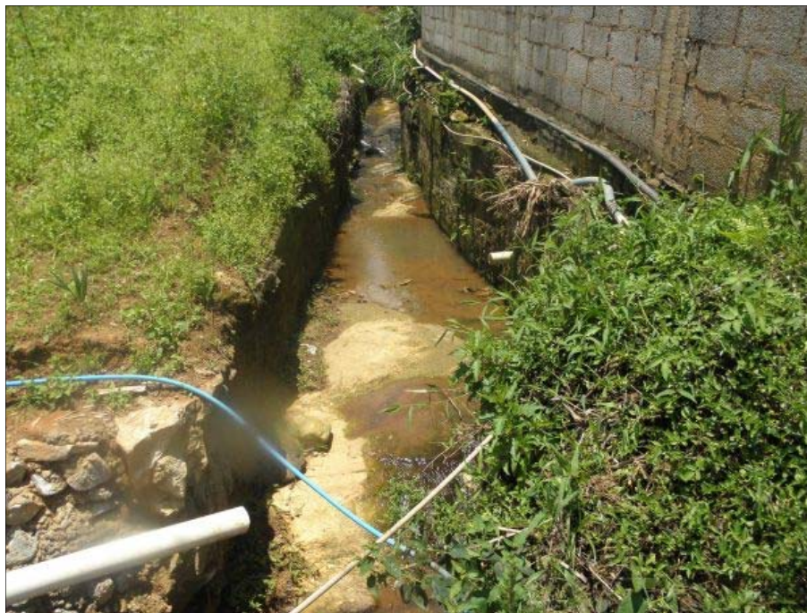
Figura 2.89. Esgoto a céu aberto.
