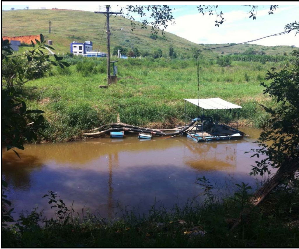
Figura 2.45: Captação Superficial do Rio Preto – Atualmente.
