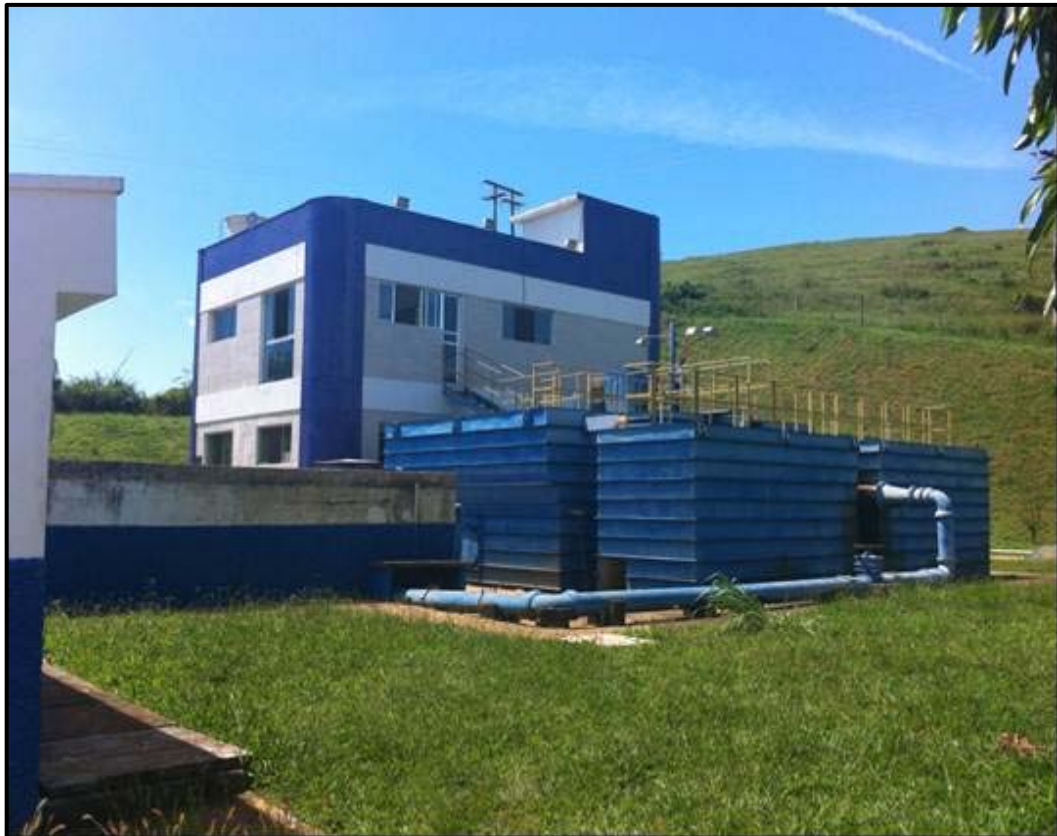
Figura 2.43: Estação de Tratamento de Água Rio Preto - Concluída
