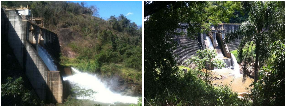
Figuras 2.68 e 2.69 Captação superficial do Rio Glória.
