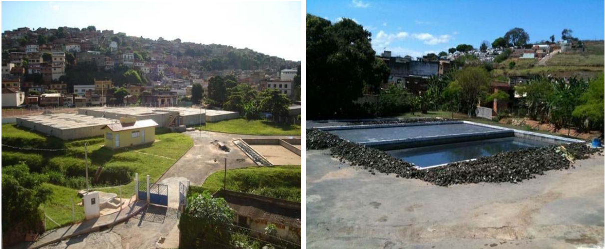
Figura 2.86 e 2.87.ETE Safira - Leito de Secagem do Lodo.
