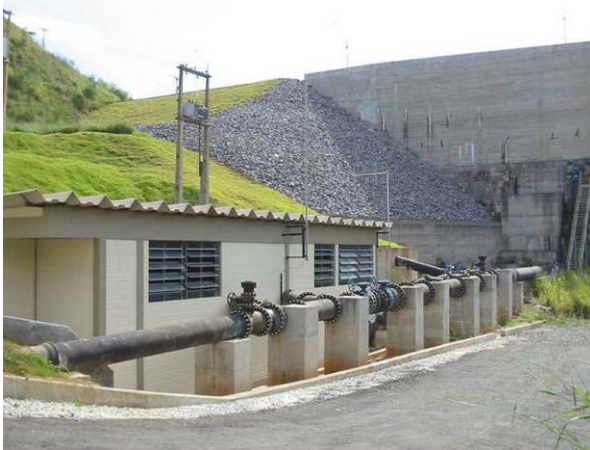
Figuras 2.70 e 2.71. Adutora de Água Bruta no rio do Glória e adução até a ETA da Gávea.
