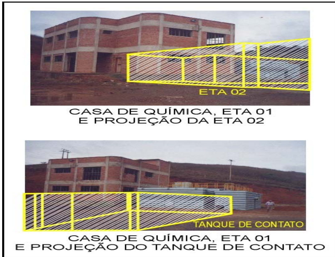
Figura 2.42: Estação de Tratamento de água Rio Preto – Em andamento.
