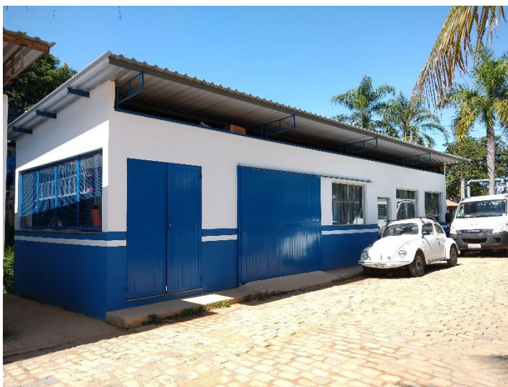
Figura 2.1.4-2: Sala de Eletromecânica localizada na ETA Gávea.
