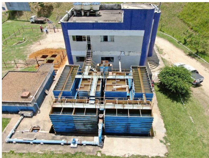
Figura 3.1.1.2-16: Imagem 02 da ETA Rio Preto - 2019.
