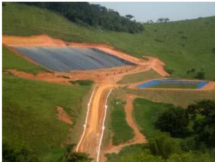
Figura 6.1.2.7-1 – Vista do Aterro Sanitário quando foi finalizada a obra em 2014.
