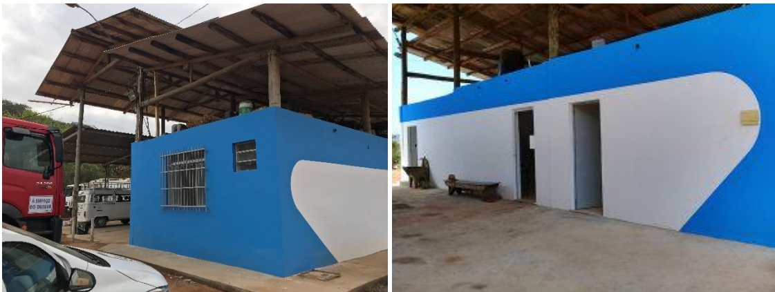
Figura 6.1.2-4 – Ponto de Apoio Administrativo/Operacional do Aterro Sanitário.
