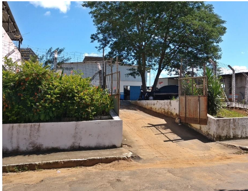
Figura 6.1.2-1 – Ponto de Apoio do DLU – Bairro Boa Esperança.
