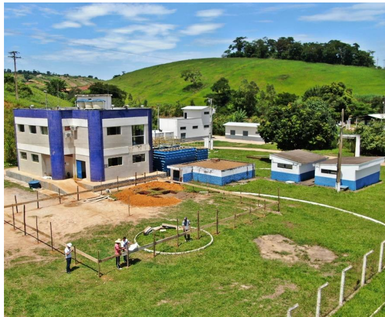
Figura 3.1.1.2-15: Imagem 01 da ETA Rio Preto - 2019.
