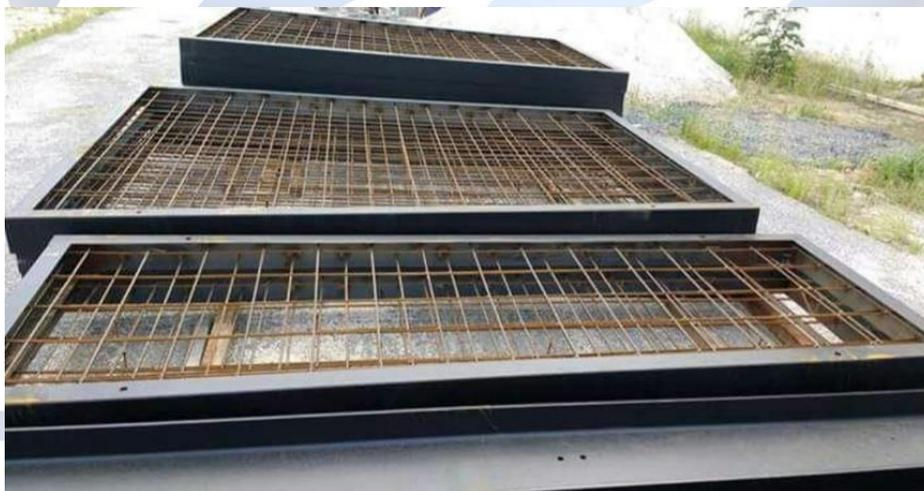
Figura 01 – Modelo de Estrutura Malha de Ferragens para Placa de Concreto Armado.
