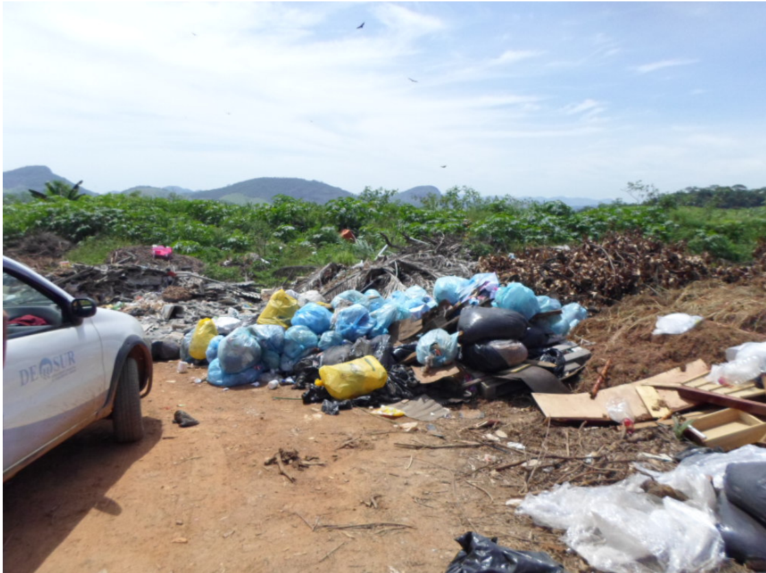
Excesso de material depositado na área de aterro sem recobrimento.
