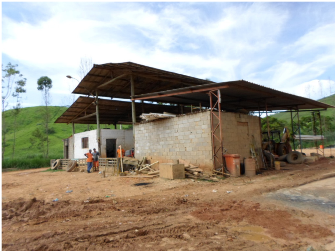
Vista posterior do galpão de triagem de lixo.
