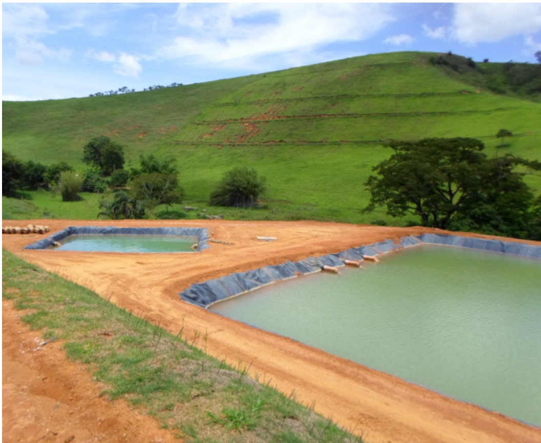
Lagos de estabilização no aterro sanitário em construção, o qual receberá o efluente do antigo aterro.
