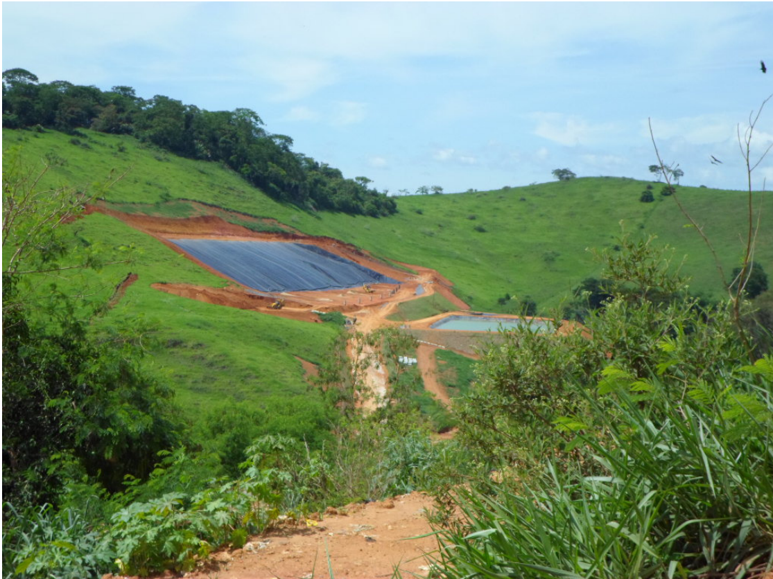
Novo aterro sanitário em construção, visto do antigo aterro.
