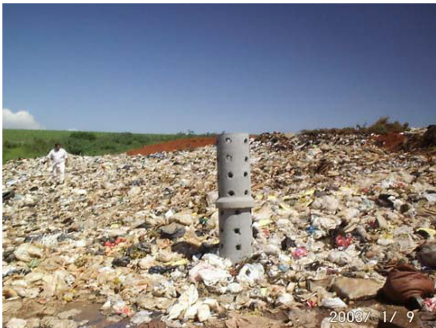
Figura 15: Dreno de gás implantado em lixão, com vistas à recuperação do mesmo. Fonte: LIMA, 2005.
