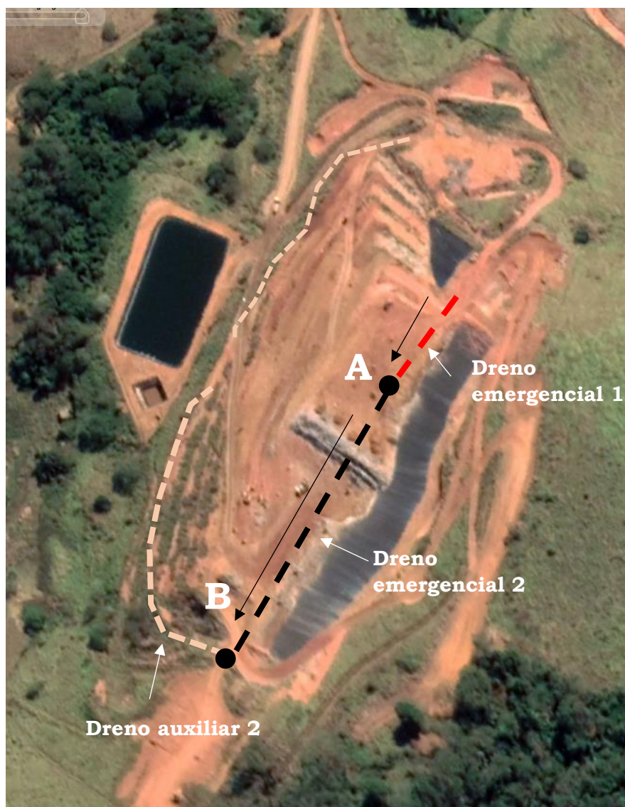
Figura 7.1-Drenos emergenciais de percolado
