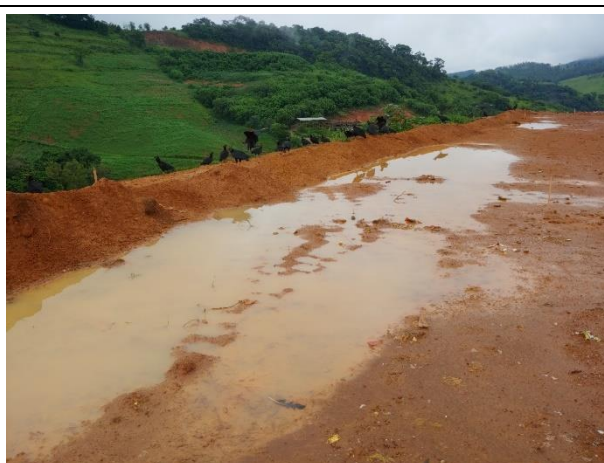
Foto 8.5- empoçamentos no platô superior
