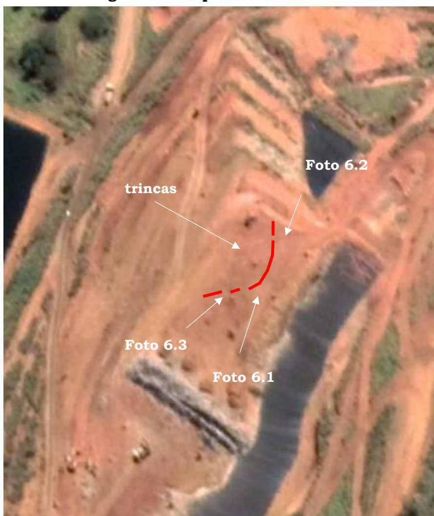
Figura 6.2- mapeamento das trincas
