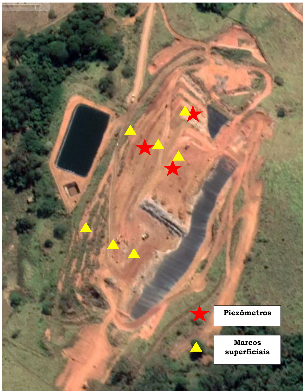
Figura 8.15. -Locação de instrumentação geotécnica - preliminar
