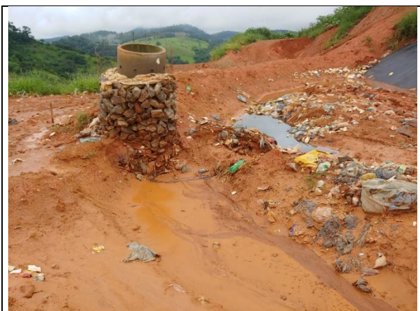
Foto 8.6- Condução de água para dentro dos drenos de gas
