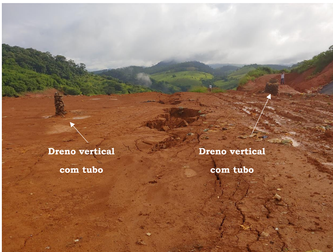
Foto 8.1 Dois tipos de drenos verticais de gás
