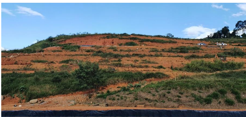
Foto 2. Outra vista frontal do Aterro Sanitário de Muriaé/MG.
