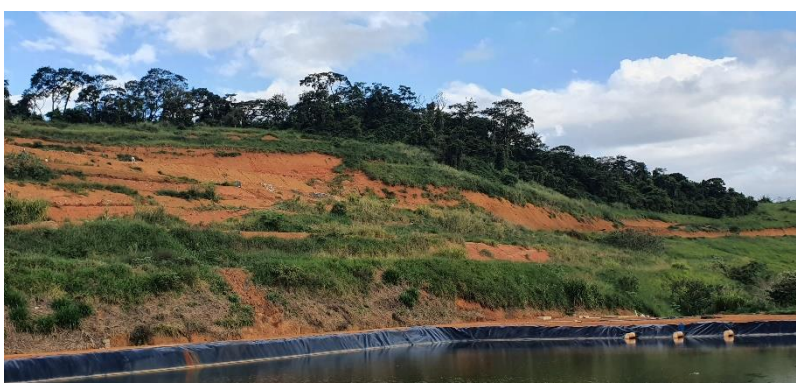
Foto 3. Outra vista frontal do Aterro Sanitário de Muriaé/MG.
