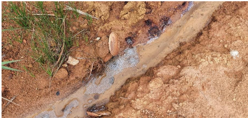
Foto 11. Afloramento de chorume no pé do talude.
