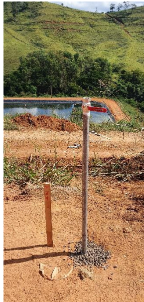
Foto 8. Piezômetro tipo Geotech instalado.
