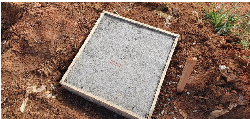
Foto 9. Marco superficial instalado.
