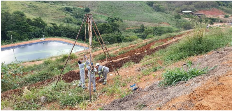
Foto 7. Instalação do piezômetro tipo Geotech.
