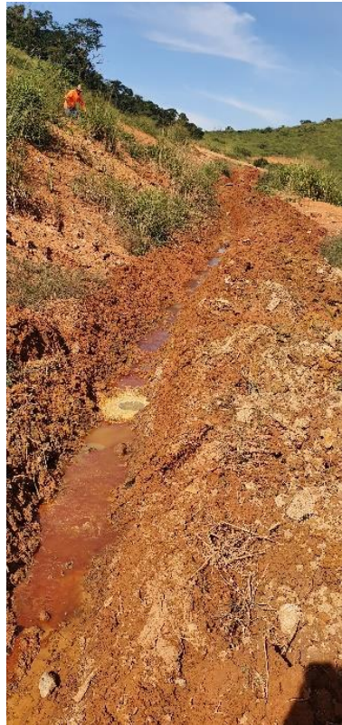
Foto 10. Pé do talude com presença de afloramento de chorume – trecho em manutenção, com instalação de drenos de lixiviados executados com bambu.
