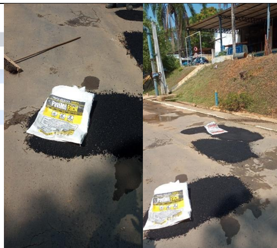
Foto – aplicação na ETA GÁVEA
