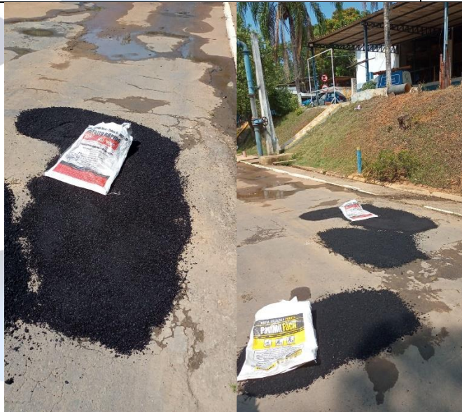
Foto – aplicação na ETA GÁVEA
