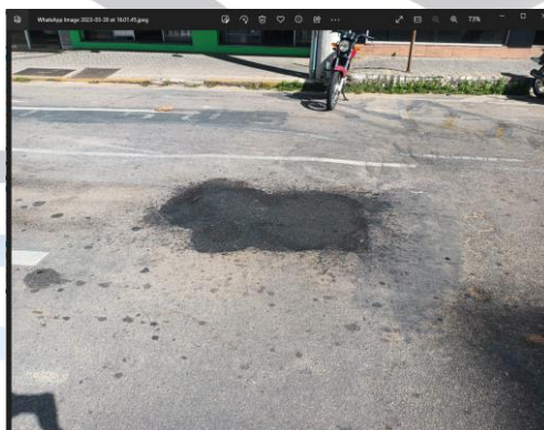
Foto – aplicação na Av. Doutor Passos, em frente o BOB’S.
